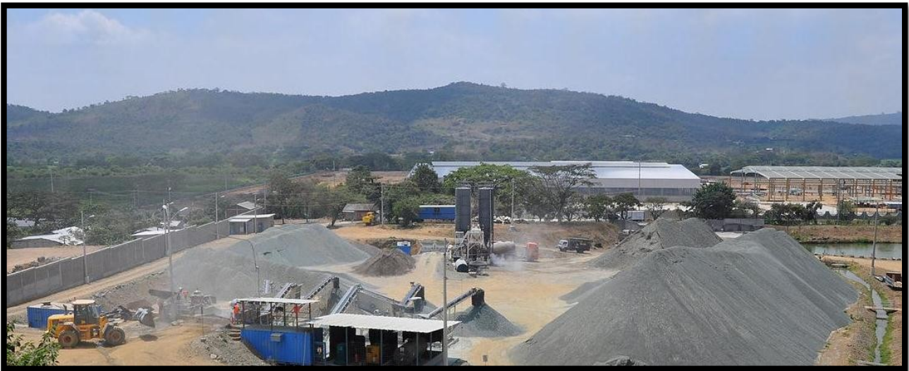
Figura 1-1: Planta Licosa Ingeniería y construcción.
