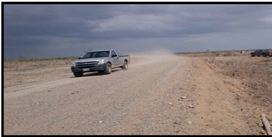
Figura 17 Lastrado de vía San Antonio –San Miguel – Barrio Lindo en el cantón Playas año 2016
