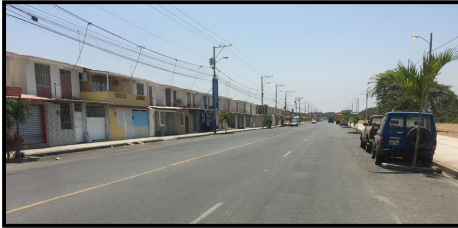
Figura 2 Vía urbana de acceso principal Mucho Lote 2
