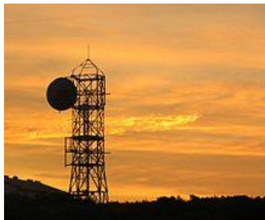
Figura 2.1: Torre de Telecomunicaciones de Wellington Nueva Zelanda Fuente: www.rtve.es
