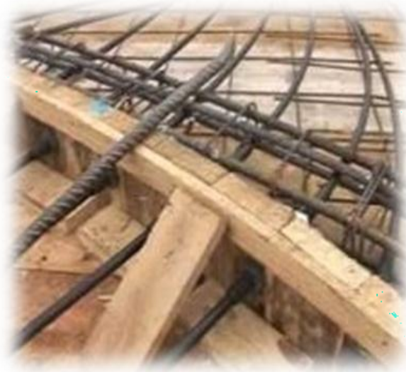
Figura 23: Ejecución de losa en hormigón pretensado
