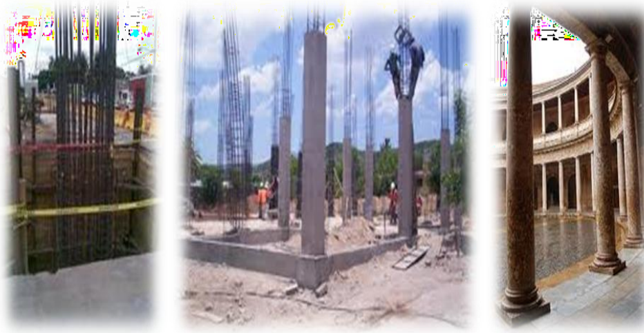
Figura 18: Columnas en diferentes fases de construcción
