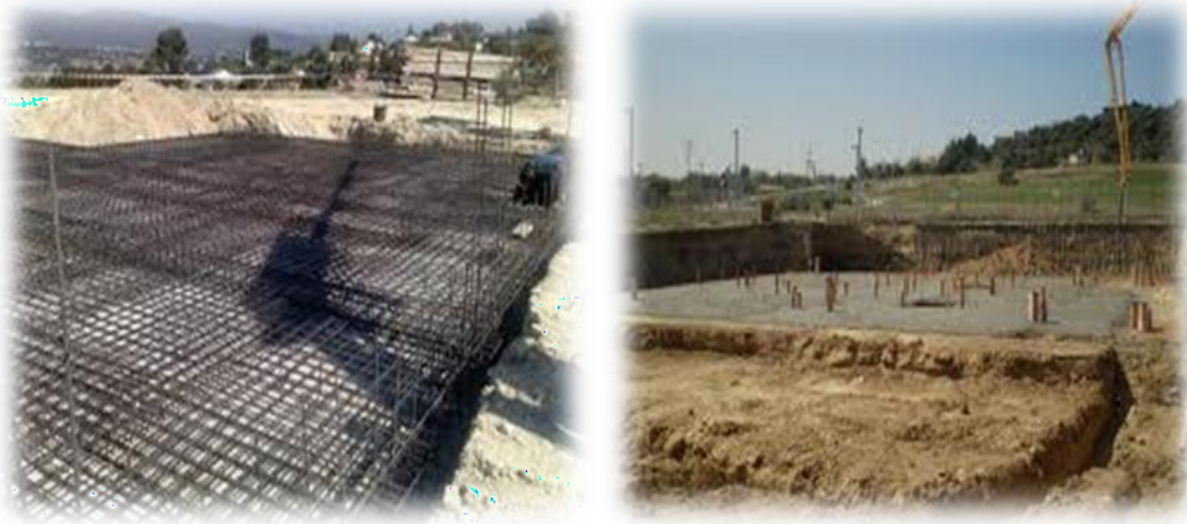
Figura 15: Losas de cimentación
