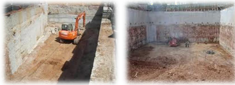
Figura 17: Muros pantalla
