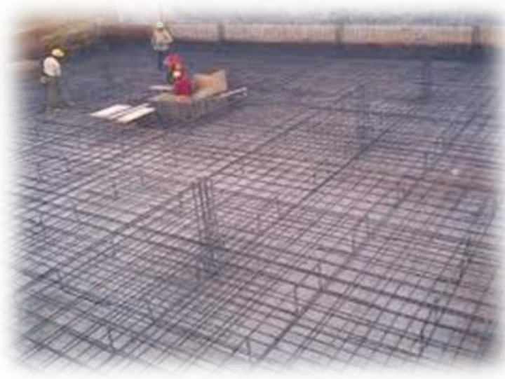
Figura 22: Losas en hormigón reforzado
