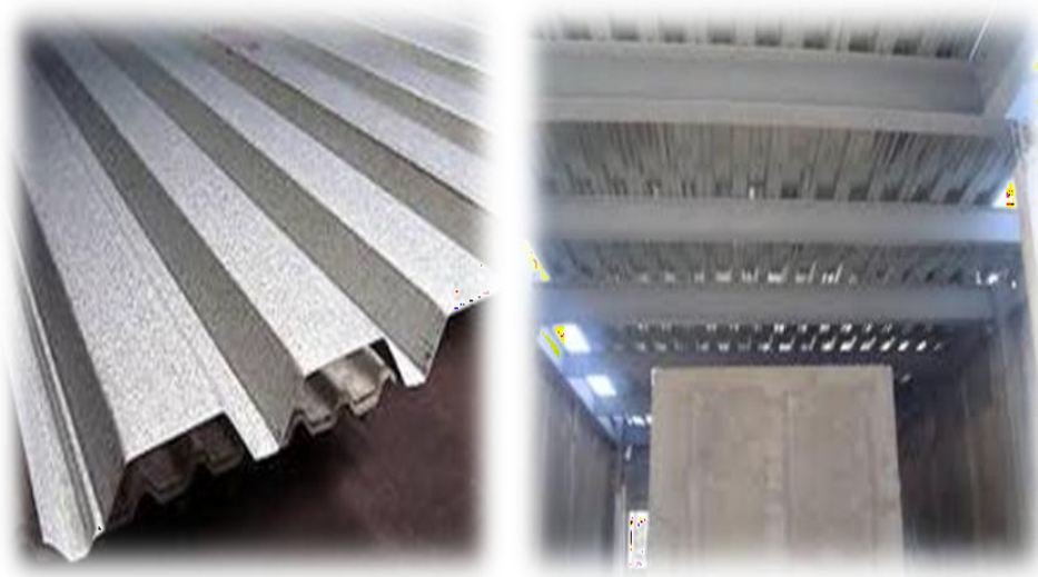
Figura 25: Losas en lámina de acero
