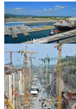
Ampliación del Canal de Panamá
