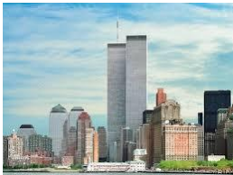
Construcción del World Trade Center (Nueva York)
