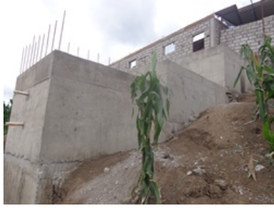
Foto 29: Vista de tanque Clarificador y Reactor
