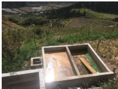
Foto 41: Vista del Tanque Lecho de Lodos y al costado izquierdo tanque de trabajo de la bomba sumergible.
