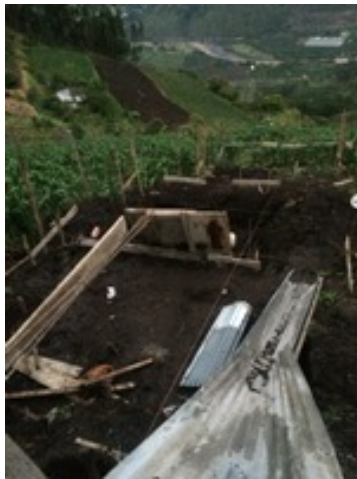
Foto 23: Colocación de bases
