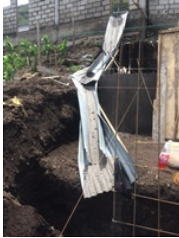
Foto 25: Bases y estructura
