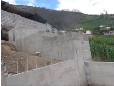
Foto 30: Otra vista de los tanques Tercera y última fase de construcción
