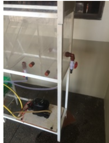
Foto 10: Vista de línea de salida de efluente
