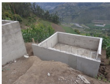
Foto 28: Vista del Lecho de lodos
