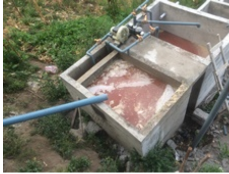
Foto 37: Vista del llenado del Primer Tanque
