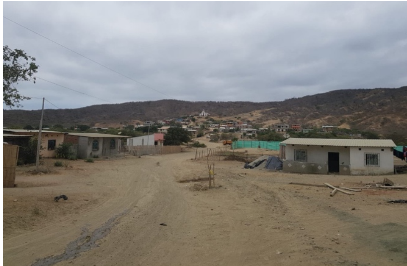
Ilustración 14.- Evidente falta de planificación urbana
