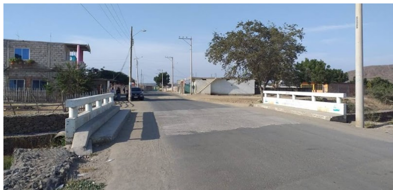
Ilustración 13. Viaducto - Vía San Juan
