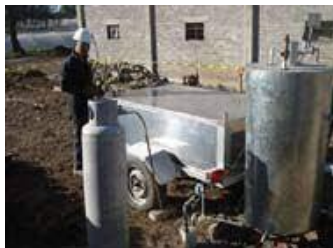
Figura 3. Caldero de vapor de agua.
