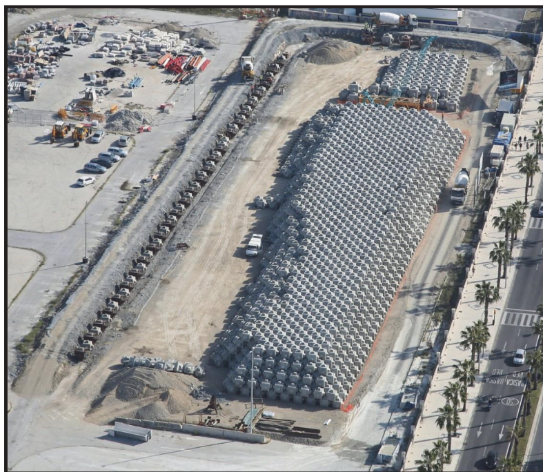
Ilustración 53. Parque de Cubípodos con grúas móviles en el Puerto de Málaga.
