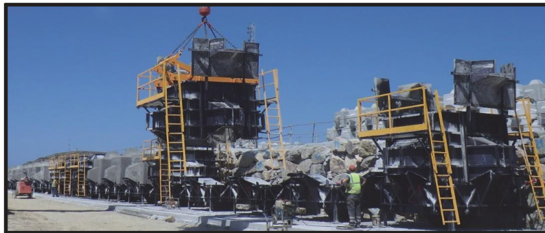
Ilustración 47. Encofrados verticales del Cubípodo® de 19 m 3 con sus bases
