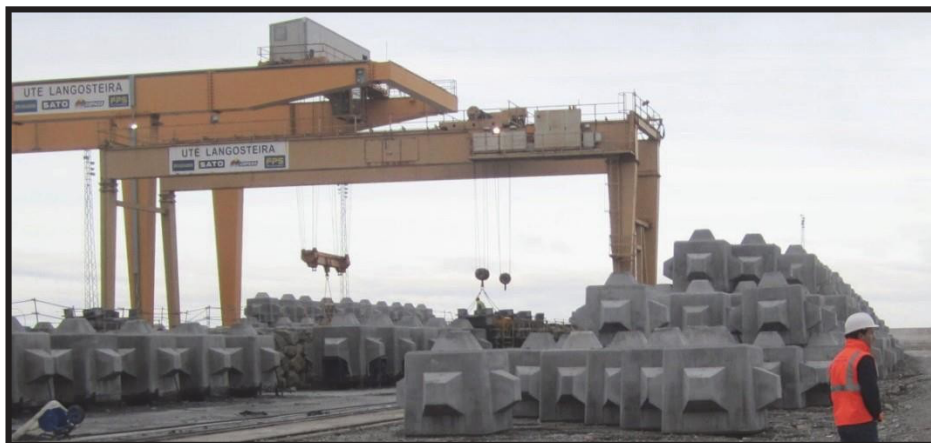
Ilustración 50. Parque de Cubípodos atendido con puentes grúa (Punta Langosteira).
