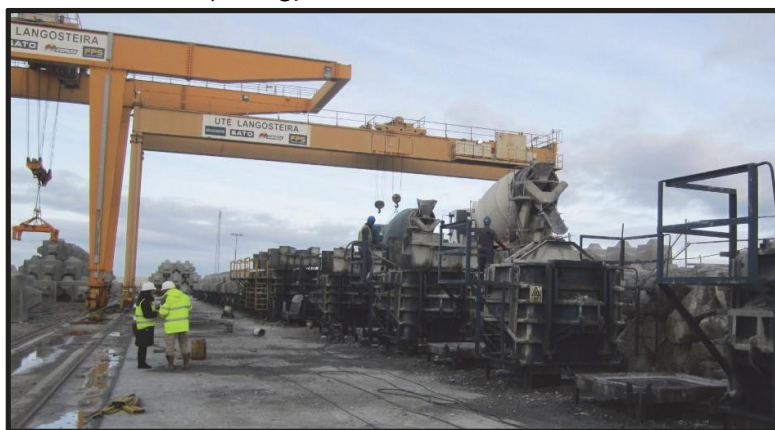
Ilustración 51. Encofrados y línea de producción de Cubípodos de 25t (10.6 m 3 ).
