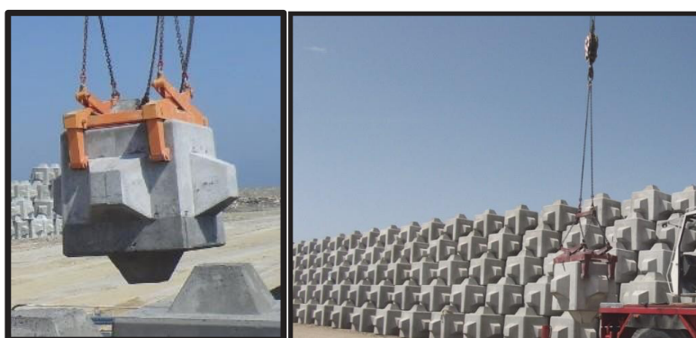
Ilustración 48. Pinzas de presión dobles para la manipulación de Cubípodos.
