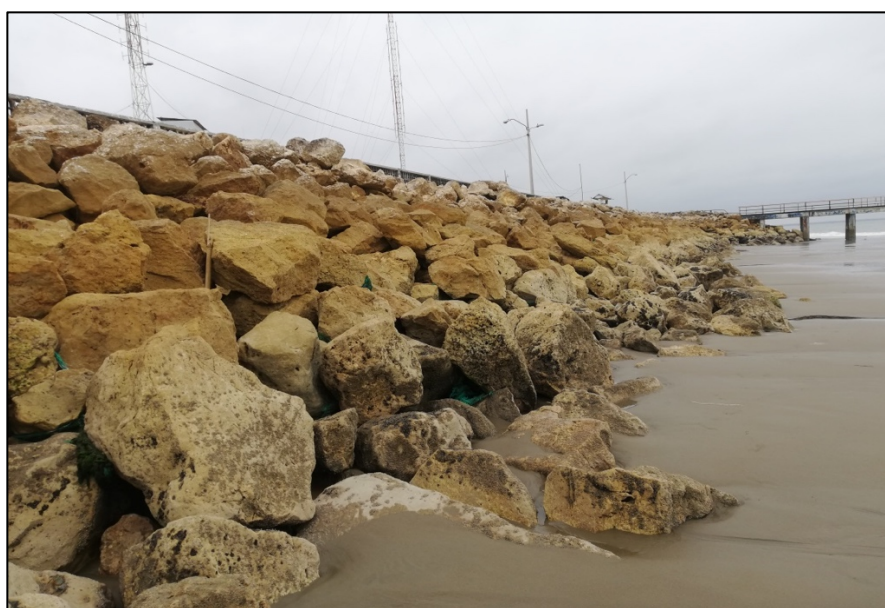
Ilustración 42: Condición del Enrocado Presente en la Zona de Estudio
