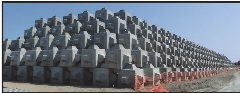
Ilustración 49. Provisión a cinco alturas en el parque de Cubípodos del Puerto de Málaga
