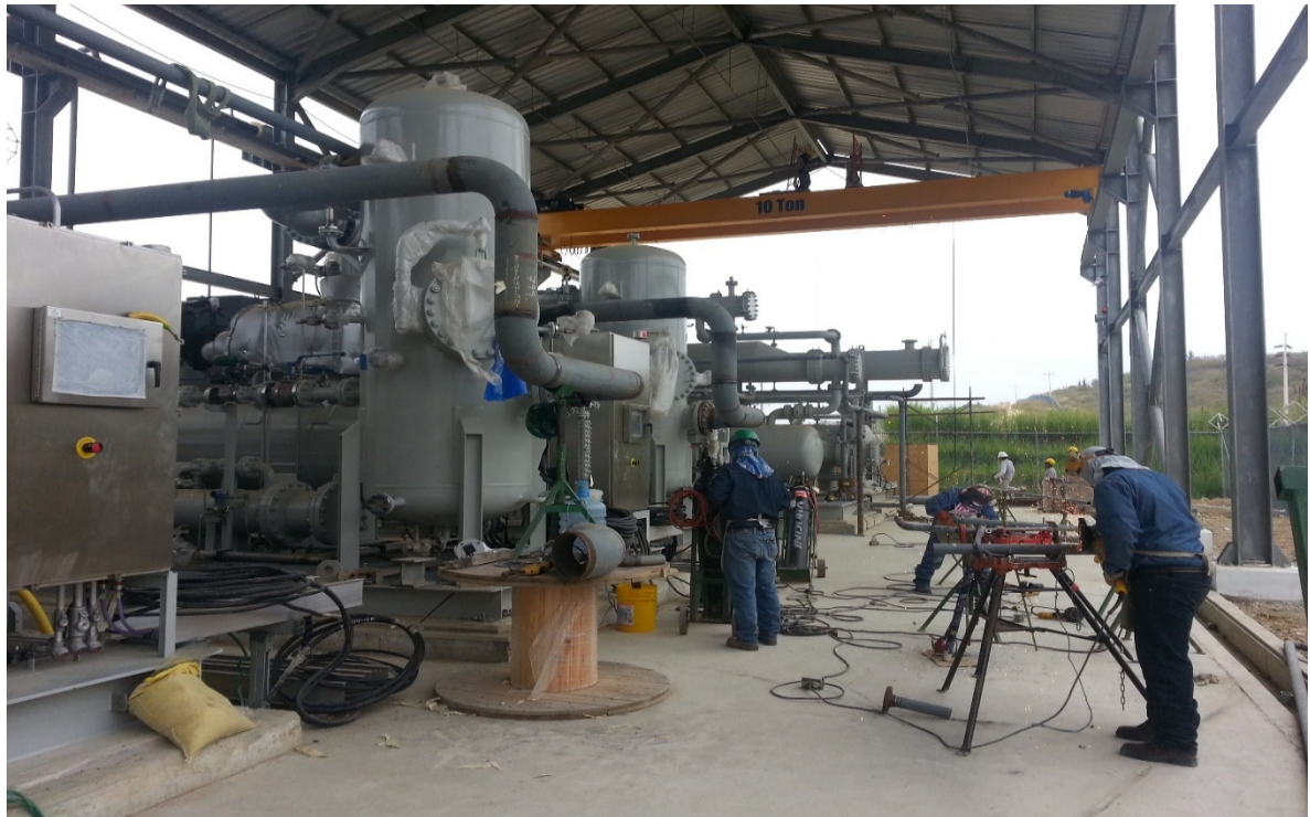
Ilustración 284.- conexonado de equipo de frío
