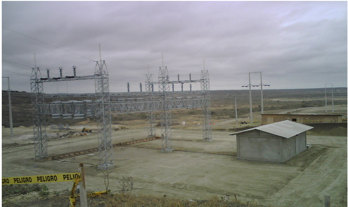
Ilustración 218.- construcción de subestación eléctrica
