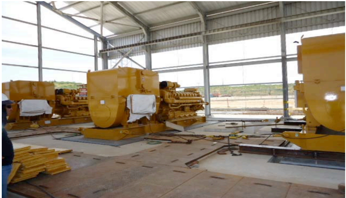
Ilustración 269.- montaje de los generadores caterpillar sobre las bases en el cuarto de generadores auxiliares
