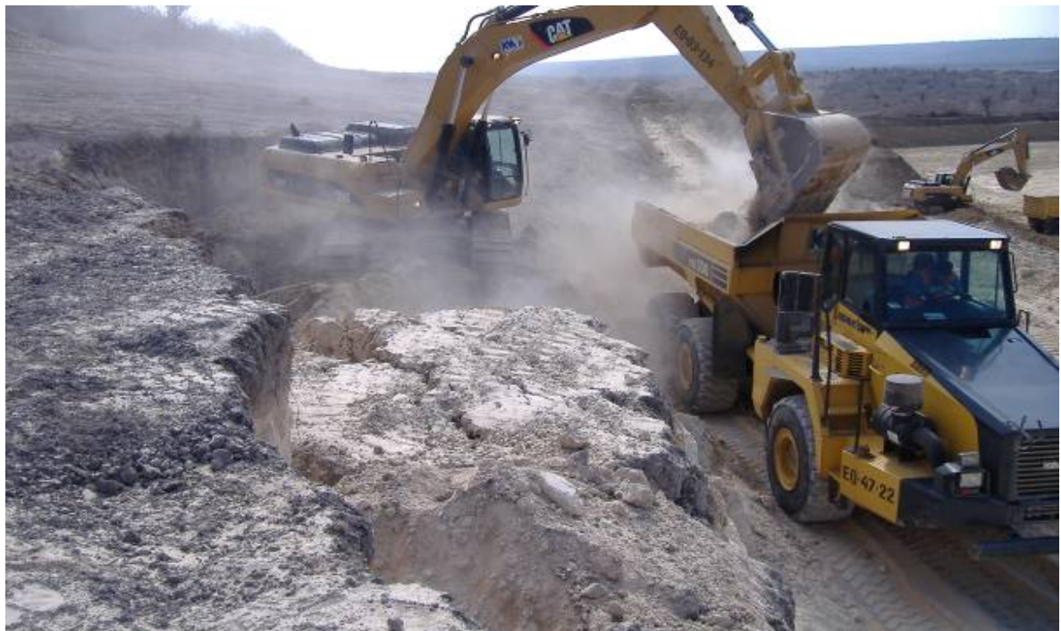
Ilustración 204.- excavación para conformación de plataforma de subestación y pipe-way
