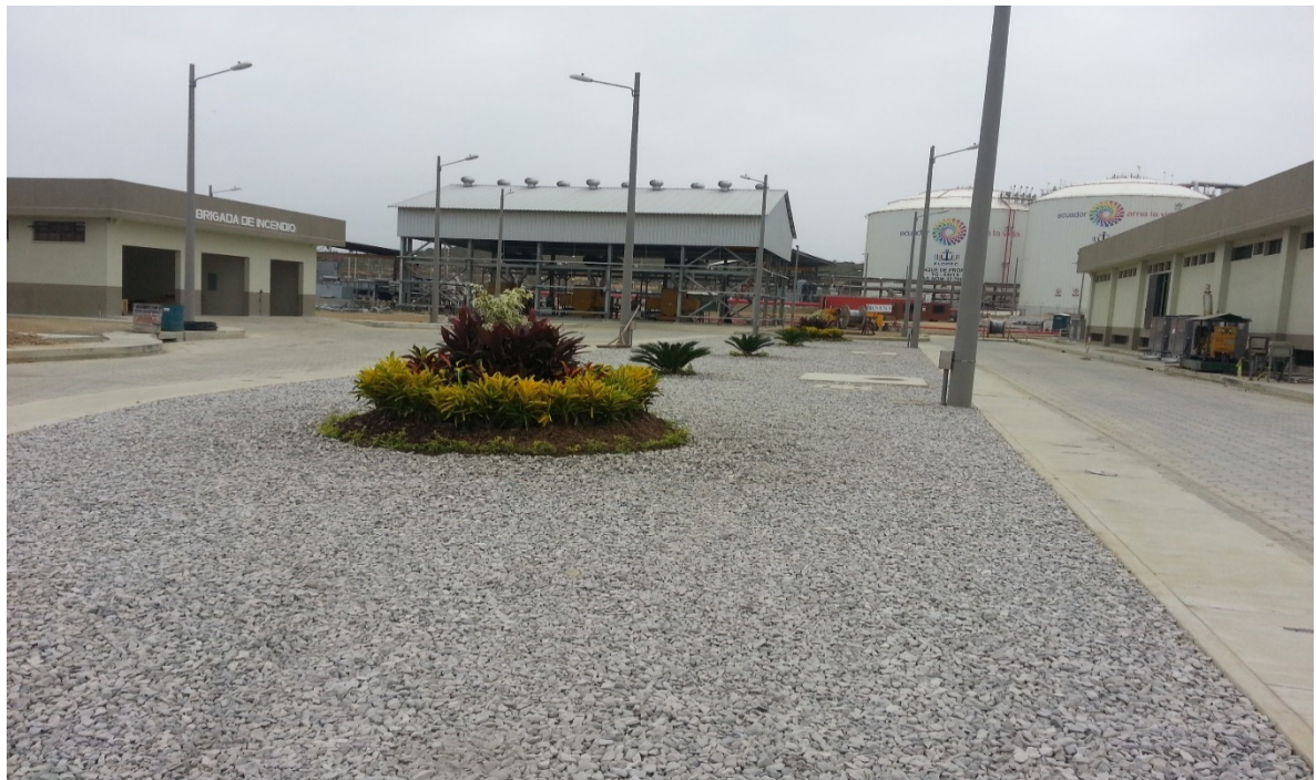
Ilustración 296.- estación contra incendio
