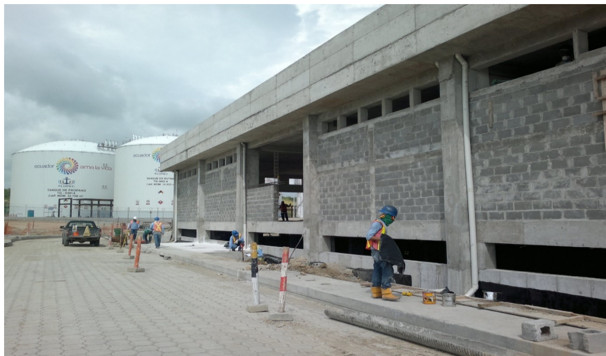
Ilustración 267.- enlucido de centro de conexonado eléctrico en la subestación s/e-01
