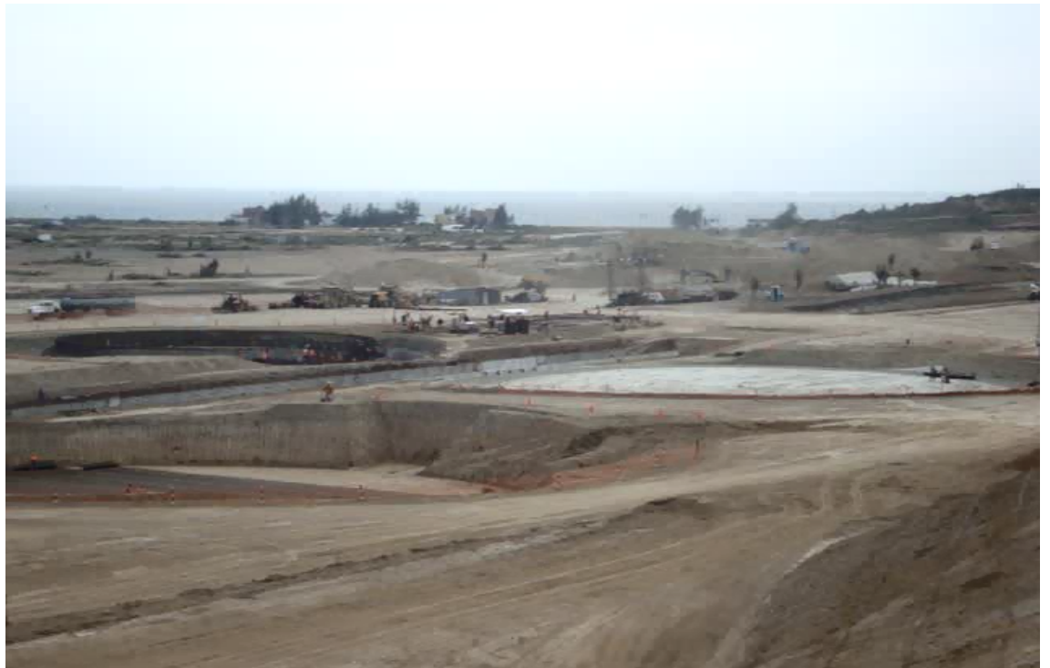
Ilustración 321.- avance de construcción del proyecto (año 2010)
