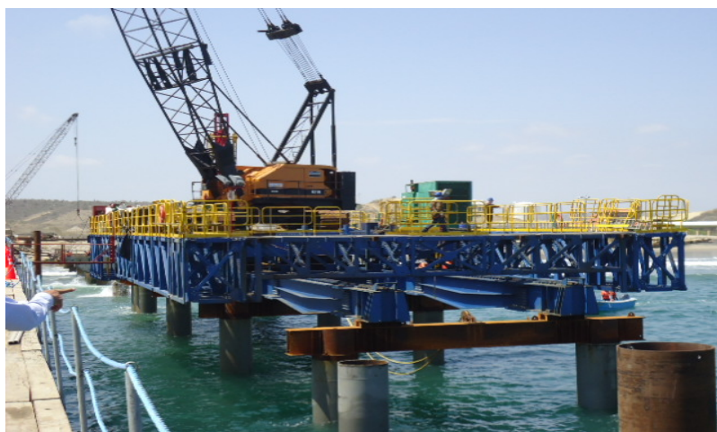
Ilustración 108.- pilotes hincados en zona de rompientes
