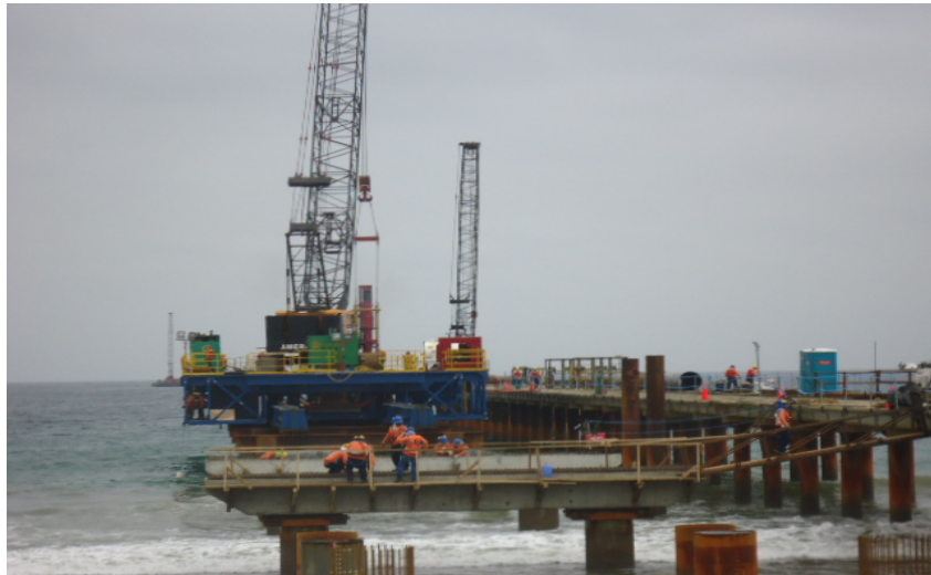
Ilustración 108.- pilotes hincados en zona de rompientes
