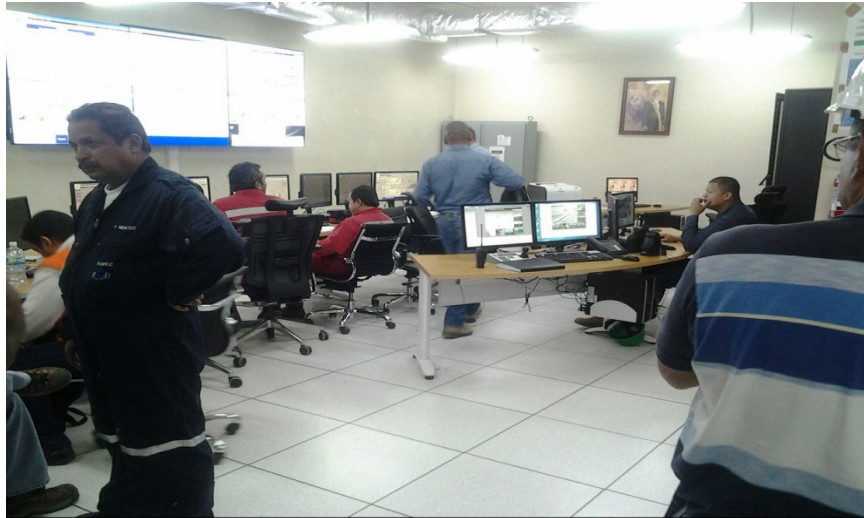
Ilustración 79.- monitoreo de descarga en sala de control de la planta de almacenamiento
