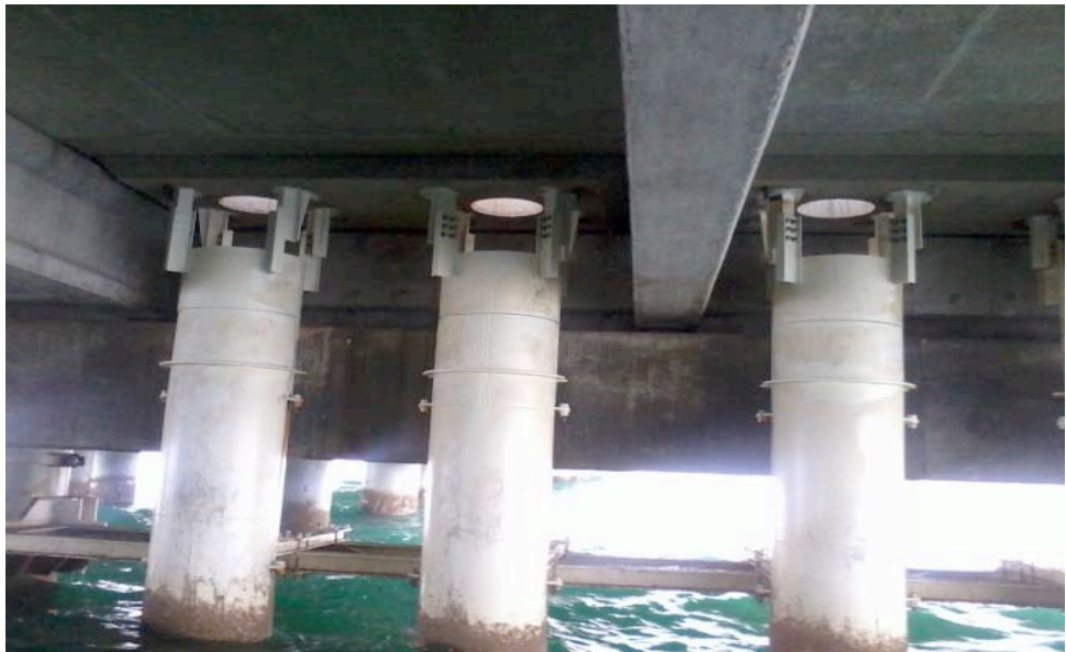
Ilustración 148.- montaje de camisas-soporte para las bombas de agua de mar
