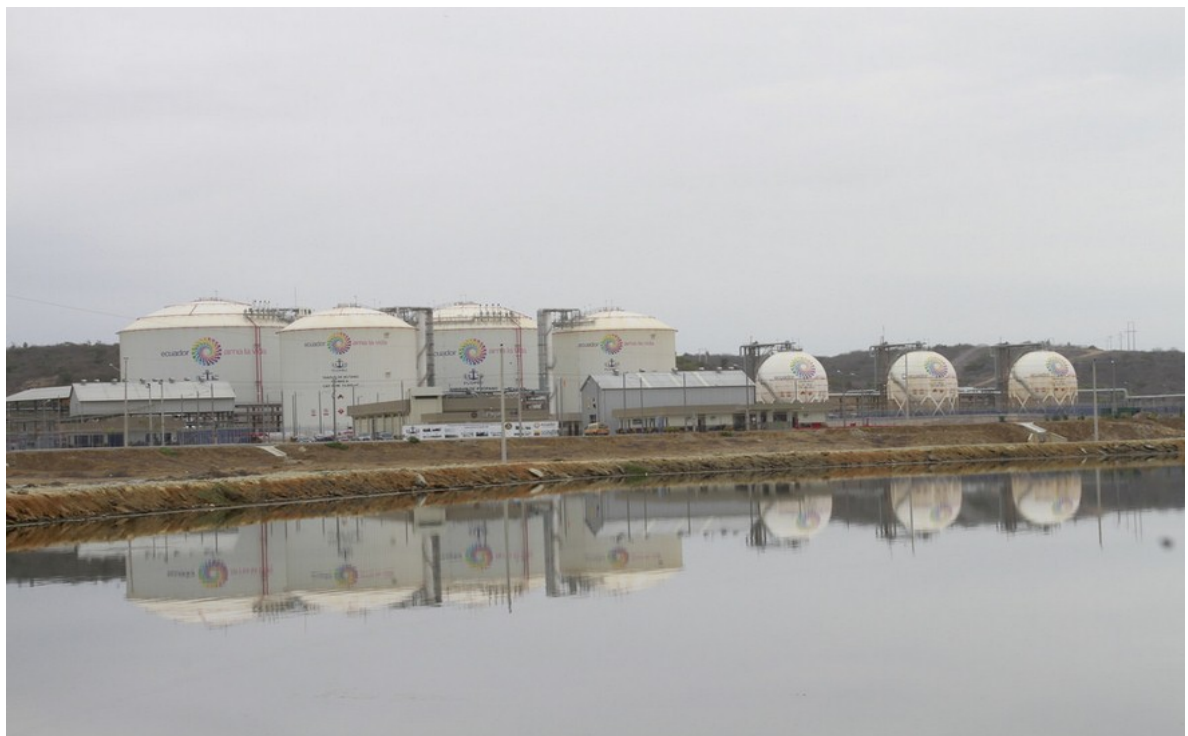
Ilustración 316.- vista panorámica de la planta de almacenamiento
