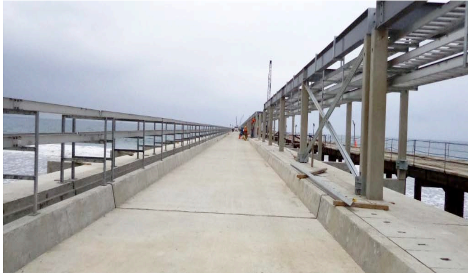
Ilustración 131.- instalación de vigas de acero y riostras laterales sobre columnas de hormigón puente de acceso.
