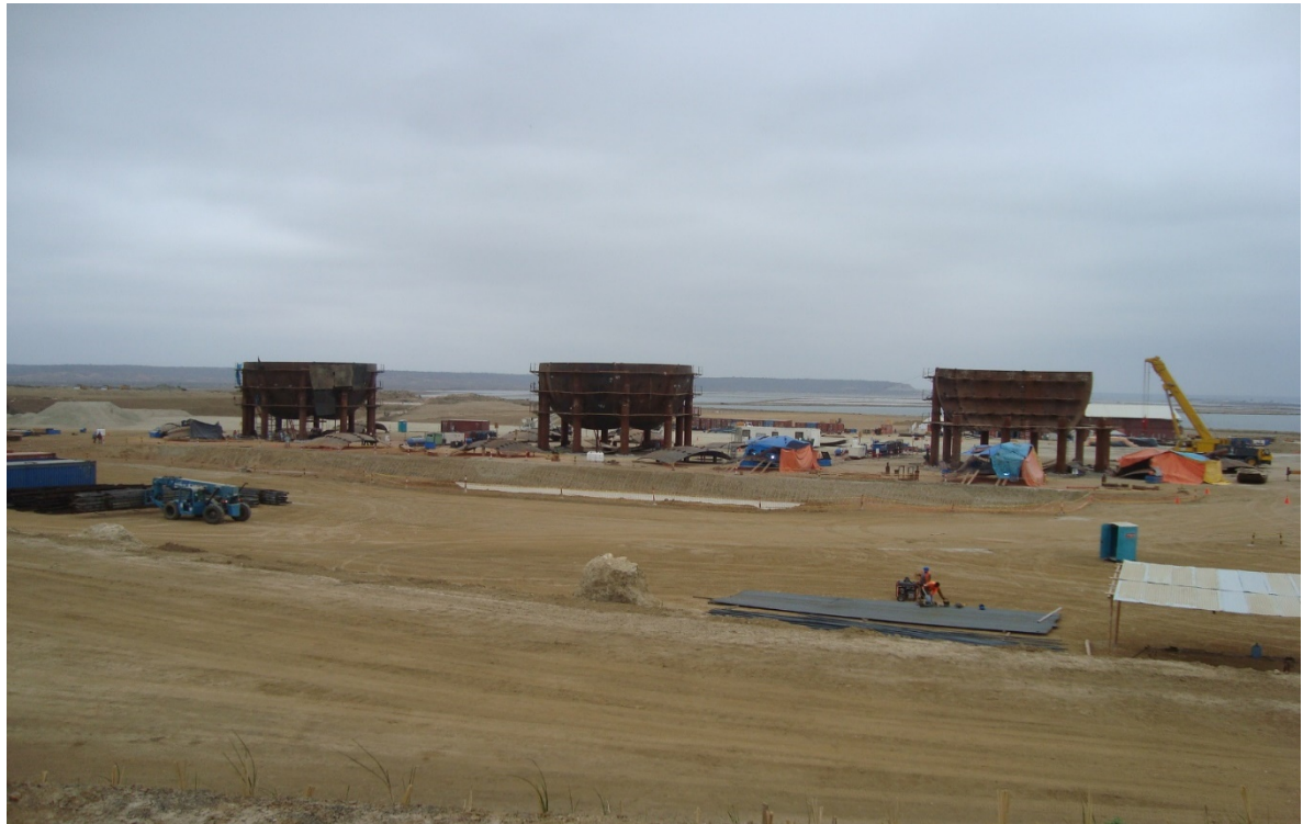
Ilustración 230.- avance de ensamblaje de esferas para glp
