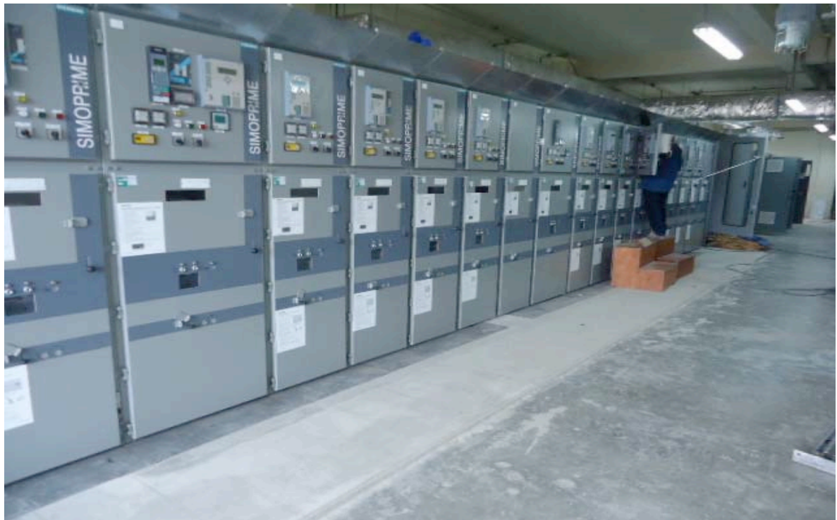
Ilustración 276.- conexionado de paneles en la subestación s/e-02
