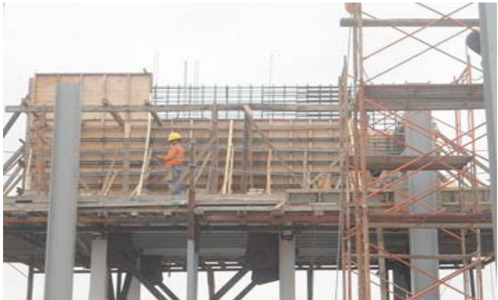
Ilustración 144.- armado y encofrado para el cuarto de control del muelle
