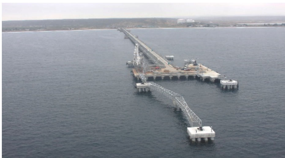
Ilustración 40.- vista aérea del puente de acceso y plataforma de operación del terminal marítimo
