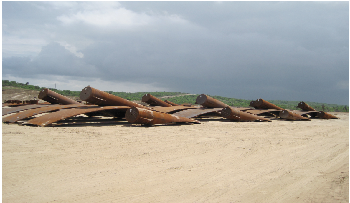
Ilustración 210.- planchas de acero para esferas
