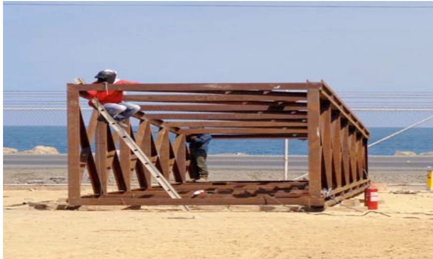
Ilustración 133.- soldadura y granallado de pasarelas de acceso a dat y dam desde plataforma de operaciones y muelle de acceso
