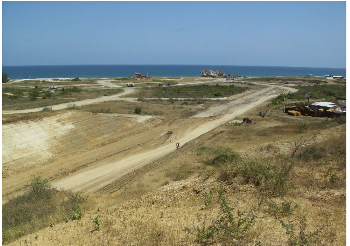
Ilustración 319.- avance de construcción del proyecto (año 2009)
