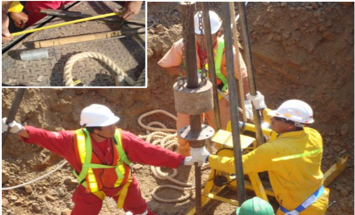
Ilustración 202.- toma de muestras para el ensayo spt para las bases de esferas
