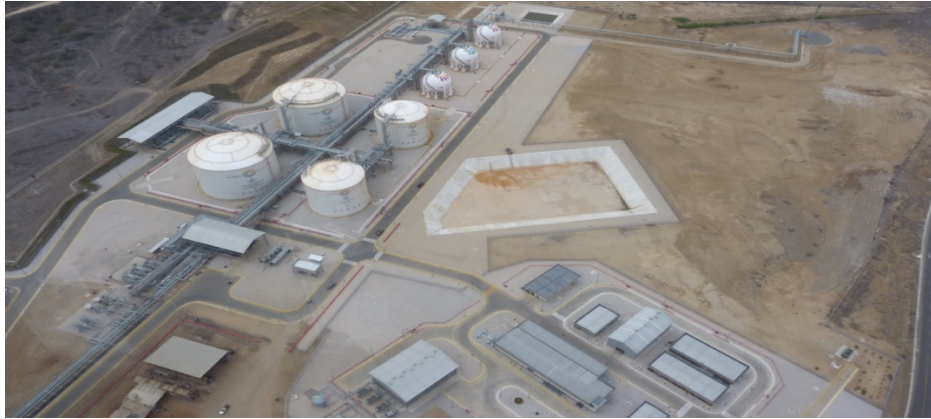
Ilustración 73.- vista de la planta de almacenamiento de GLP
