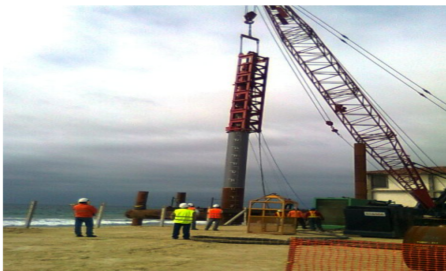
Ilustración 36.- hincado de pilotes de muelle provisional del terminal marítimo
