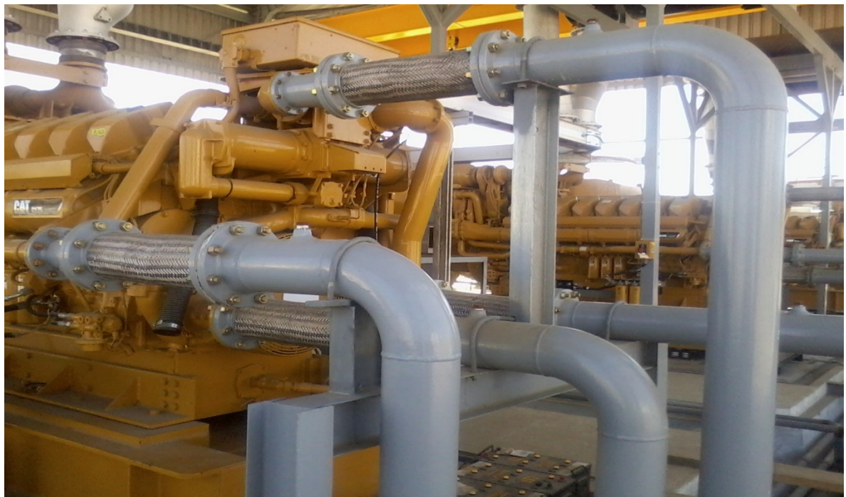
Ilustración 290.- conexión de generadores auxiliares
