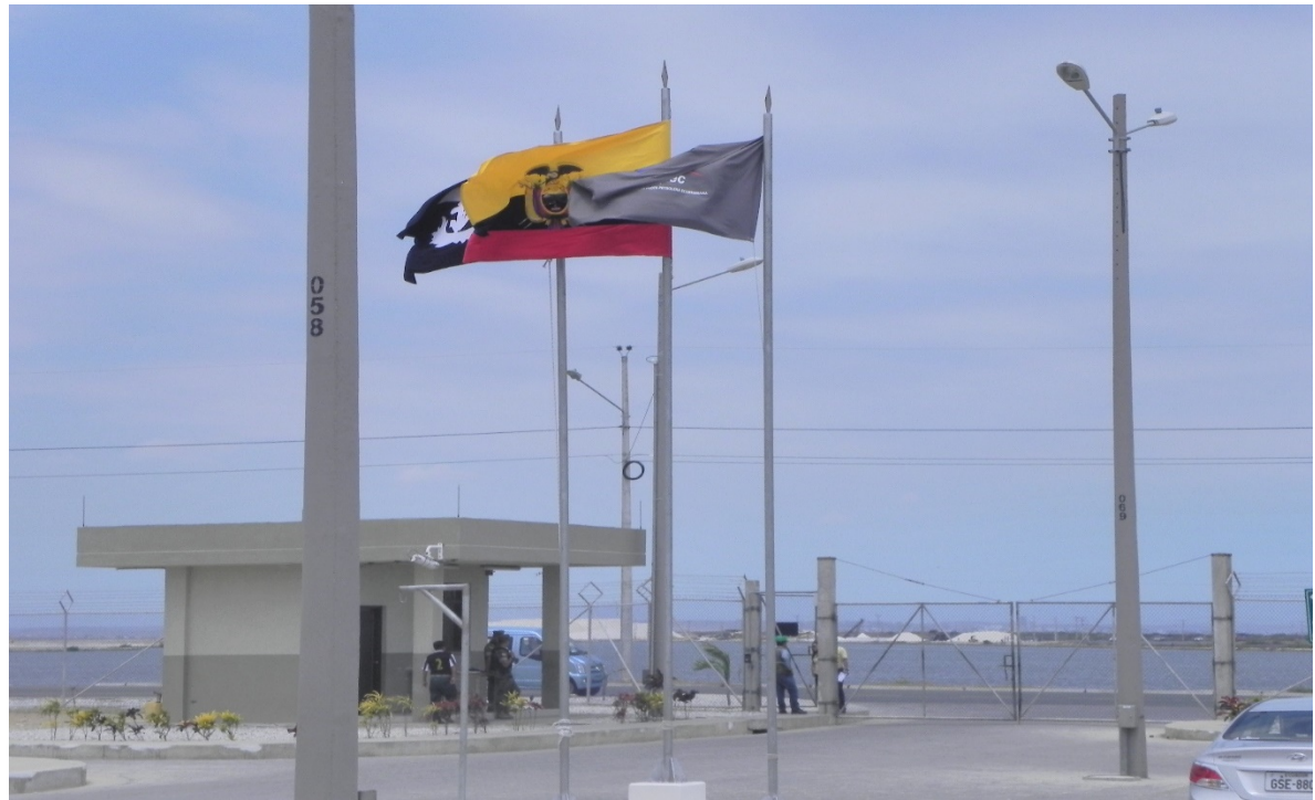
Ilustración 313.- puerta de acceso principal a la planta de almacenamiento
