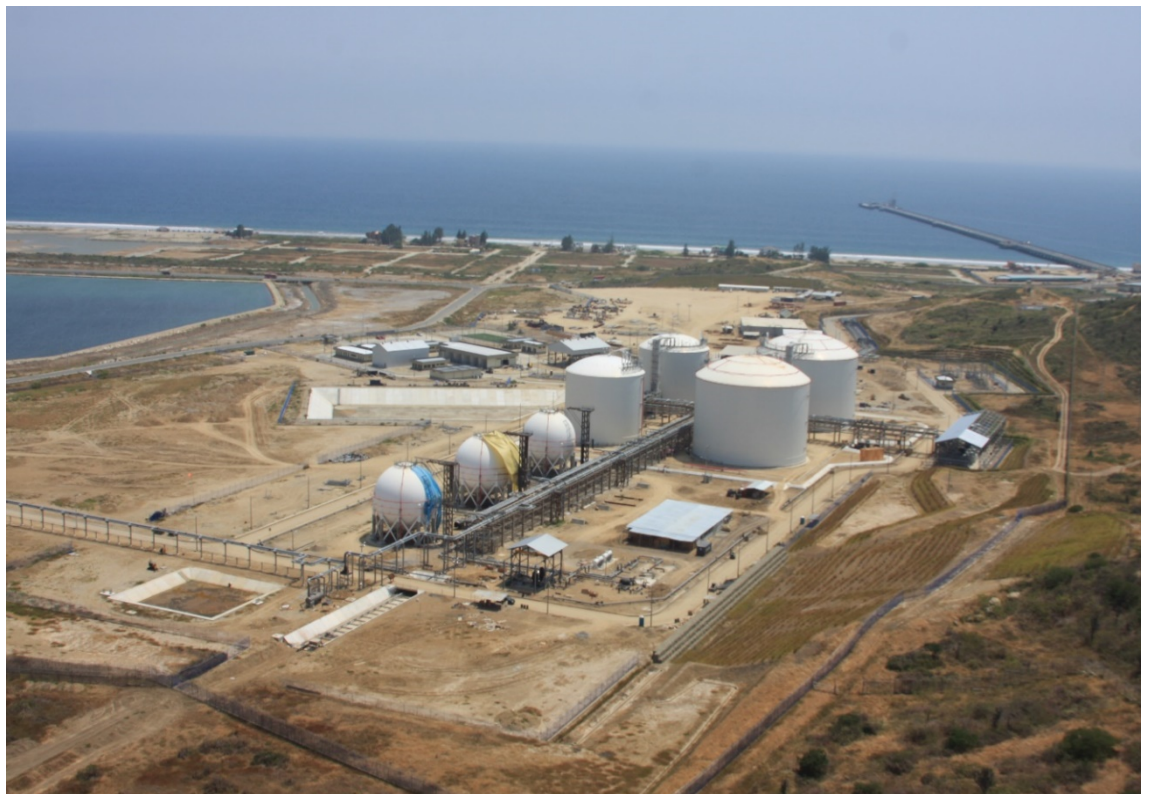
Ilustración 326.- avance de construcción del proyecto (año 2012)
