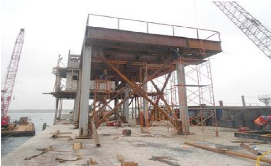
Ilustración 146.- montaje de la estructura metálica, soporte de brazos de carga y descarga
