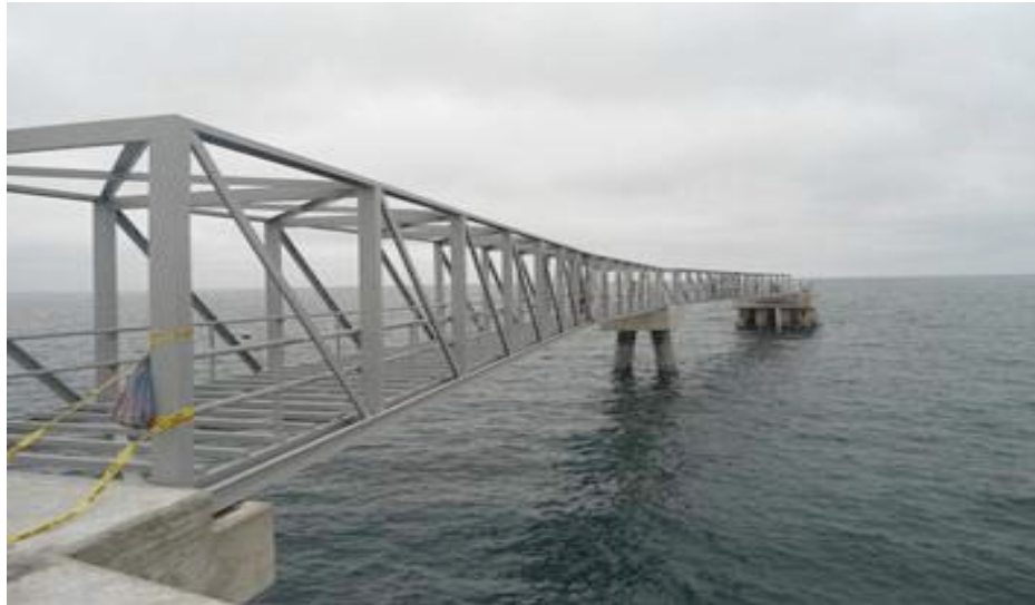
Ilustración 135.- montaje de pasarela entre dam-1 y dat-1.
