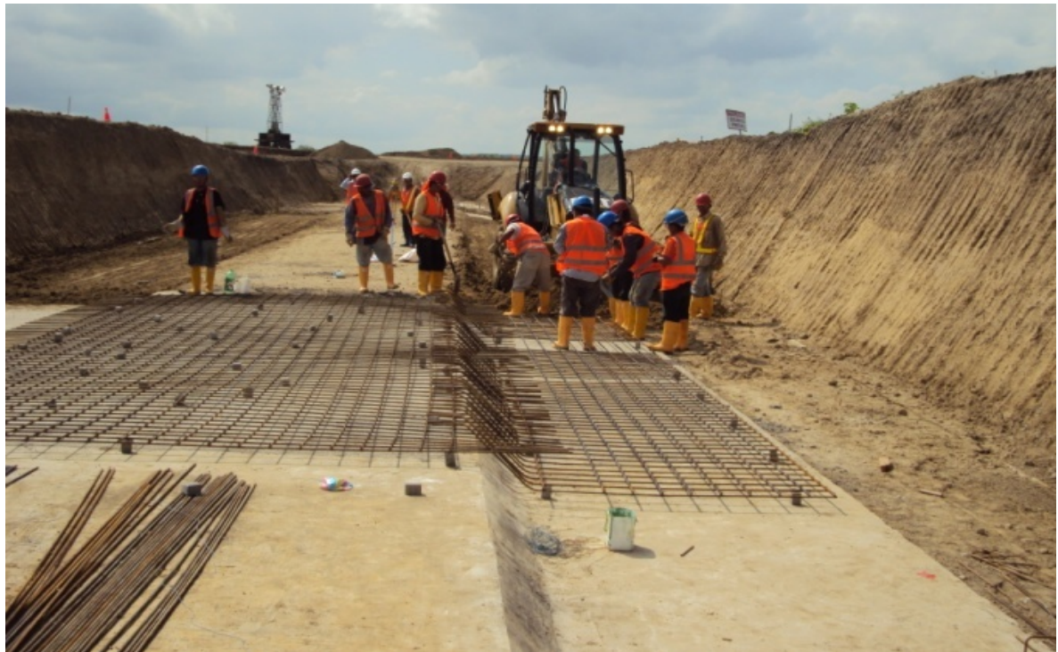
Ilustración 212.- colocación del acero de refuerzo zapata de la tubo-vía
