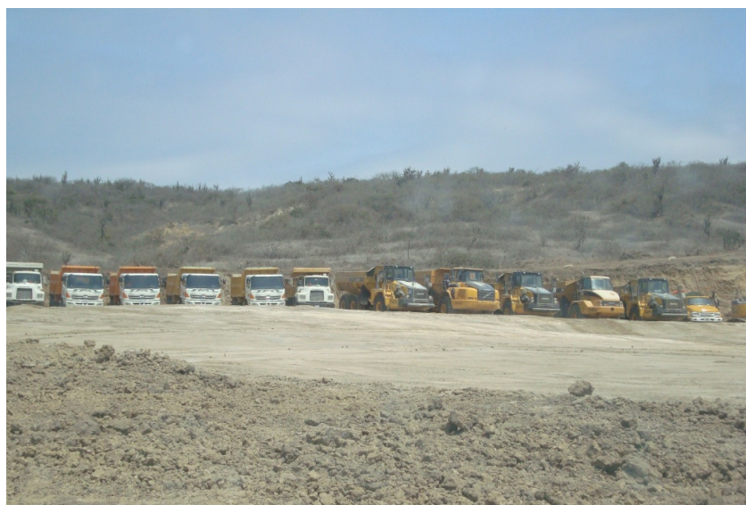
Ilustración 22.- movilización de equitransa previo inicio de trabajos
