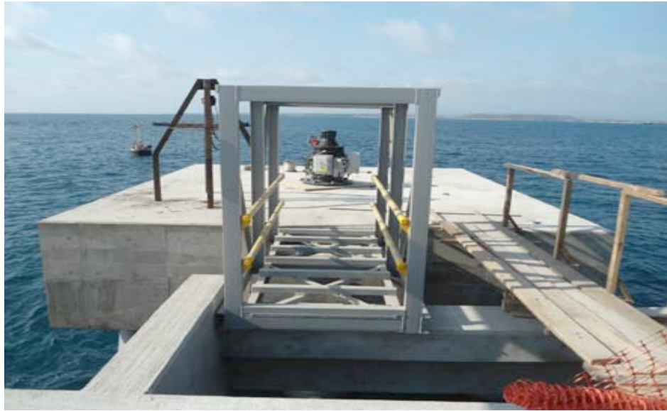
Ilustración 137.- instalación de pasarelas desde los dat 3, dat 4 y plataforma de atraque
