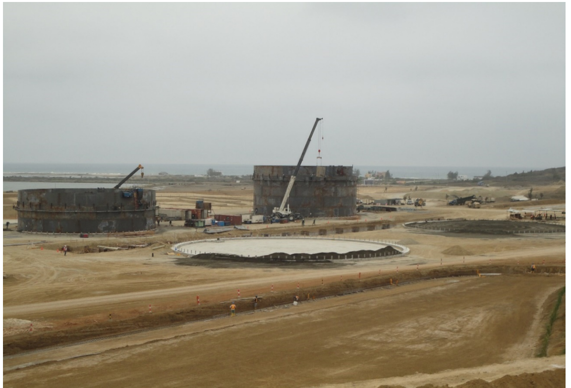
Ilustración 323.- avance de construcción del proyecto (año 2010)
