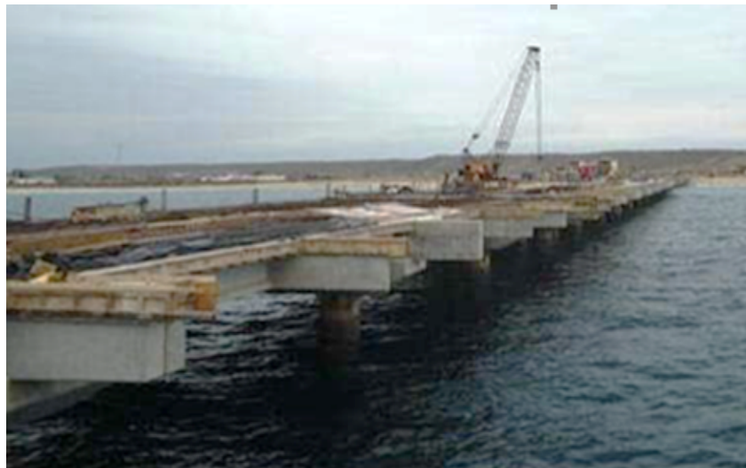
Ilustración 38.- encofrado y fundición de canaletas en puente de acceso al muelle
