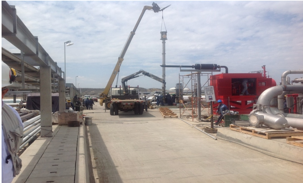
Ilustración 147.- montaje de bombas de captación de agua salada
