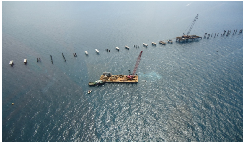
Ilustración 120.- vista aerea de avance de hinca del pantalan discontinuo
