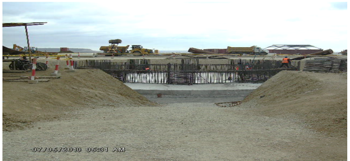
Ilustración 27.- base de esfera ef-1301 b, armado de hierro para anillo y columnas de placas
