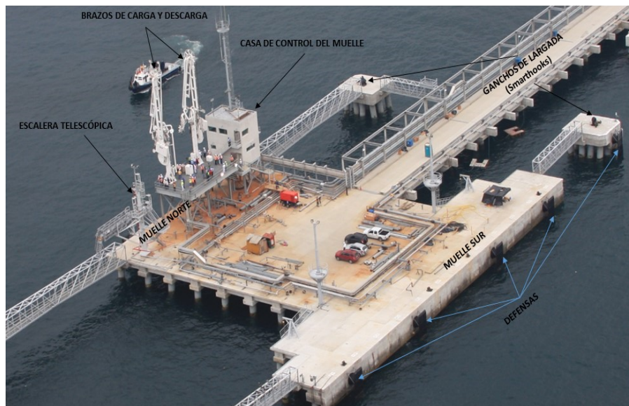
Ilustración 51.- equipos y sistemas instalados en el TMGM
