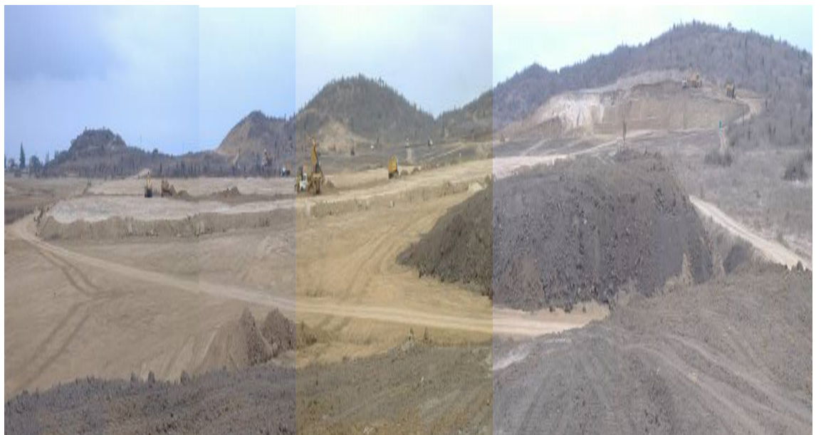
Ilustración 320.- avance de construcción del proyecto (año 2009)
