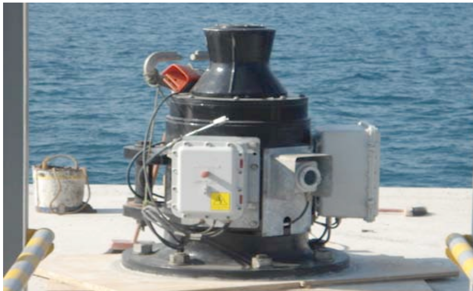
Ilustración 138.- instalación de ganchos de desenganche rápido en dolfins de atraque
