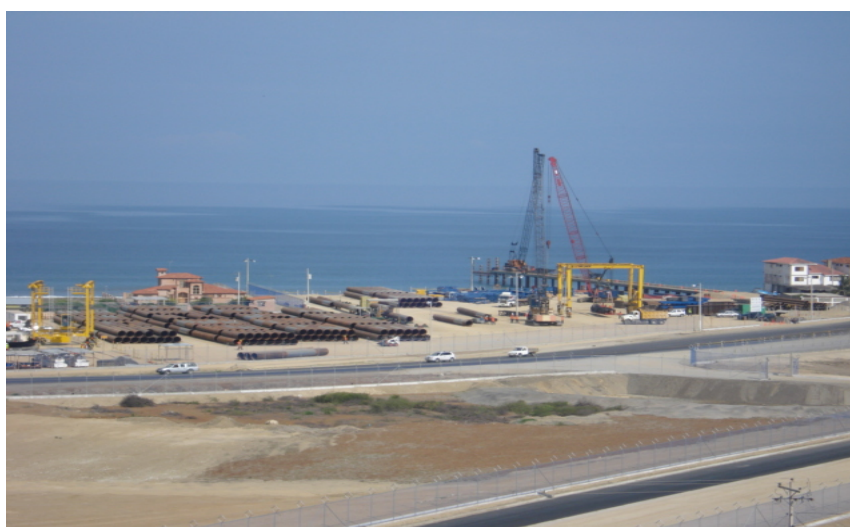
Ilustración 105.- pilotes para construcción de muelle definitivo
