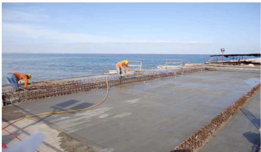
Ilustración 124.- fundición de losa del puente de acceso
