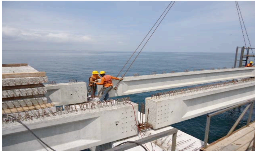
Ilustración 126.- encofrado de canaletas en puente de acceso
