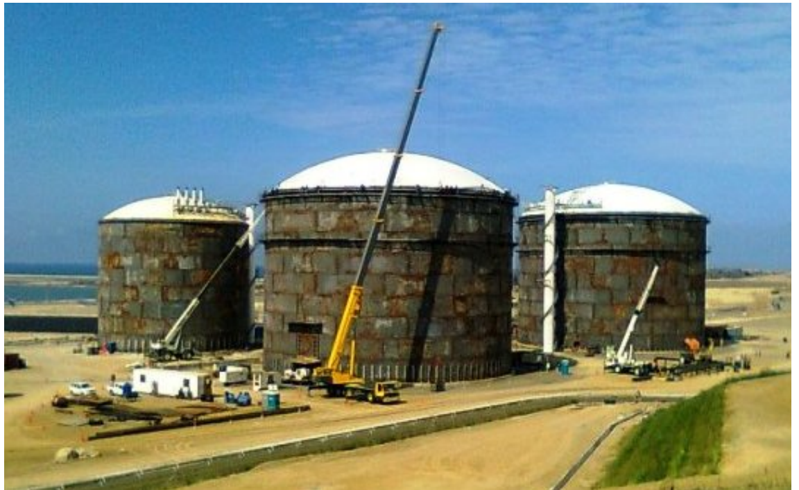
Ilustración 324.- avance de construcción del proyecto (año 2010)
