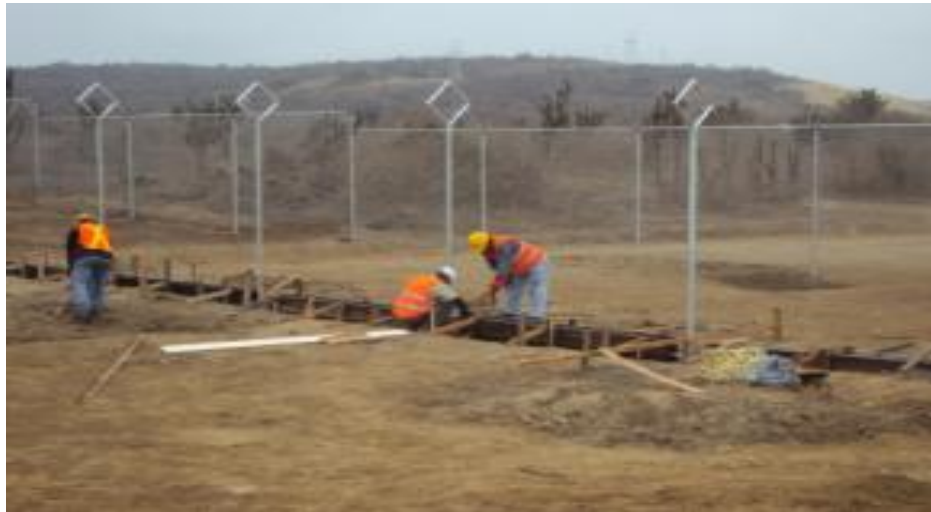
Ilustración 32.- encofrado de columna para postes
