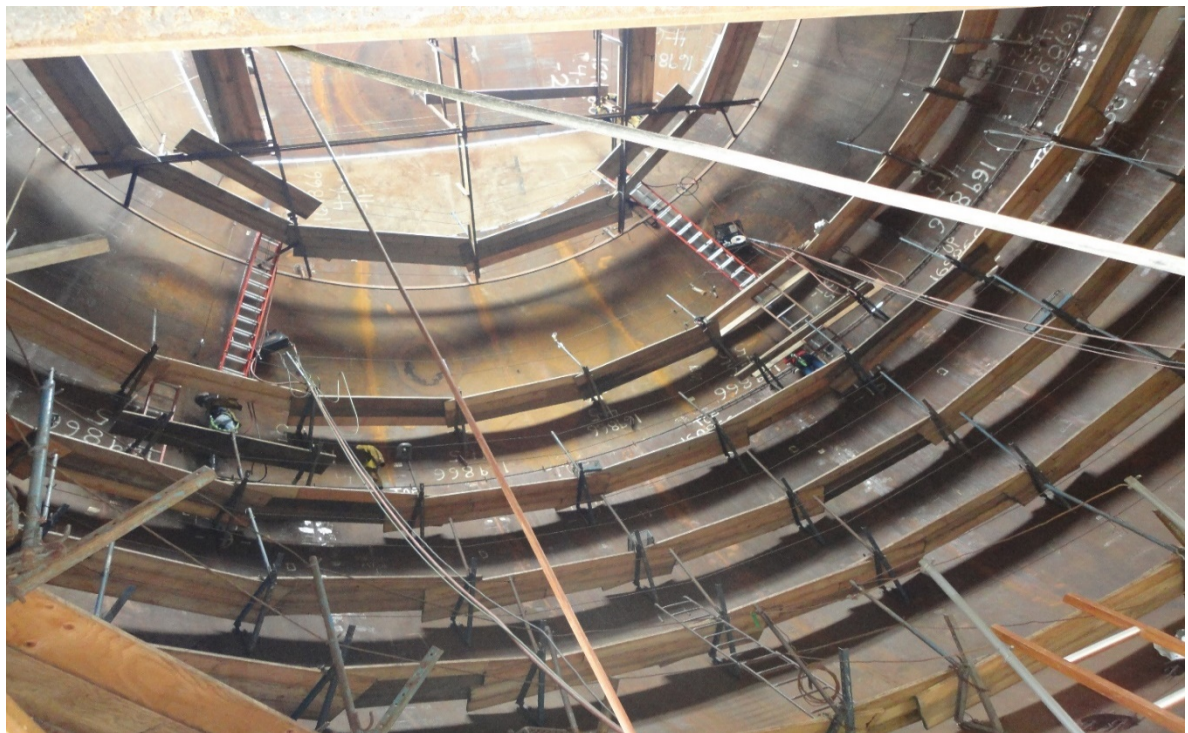
Ilustración 234.- avance de ensamblaje de esferas para glp
