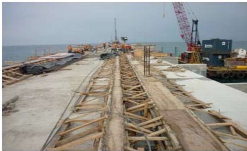
Ilustración 116.- montaje de vigas prefabricadas. Puente de acceso
