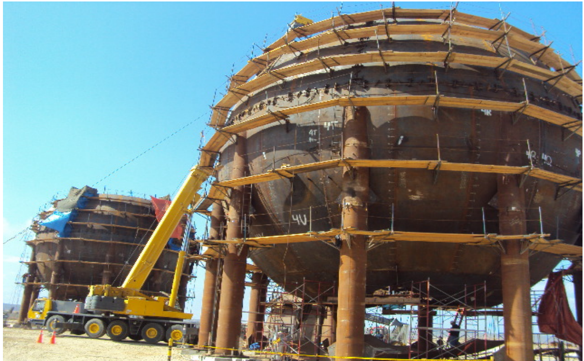
Ilustración 232.- avance de ensamblaje de esferas para glp
