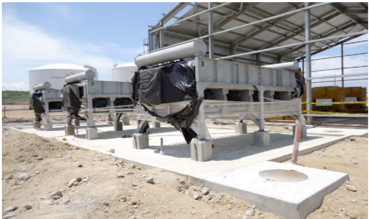
Ilustración 270.- montaje de los radiadores para los generadores caterpillar
