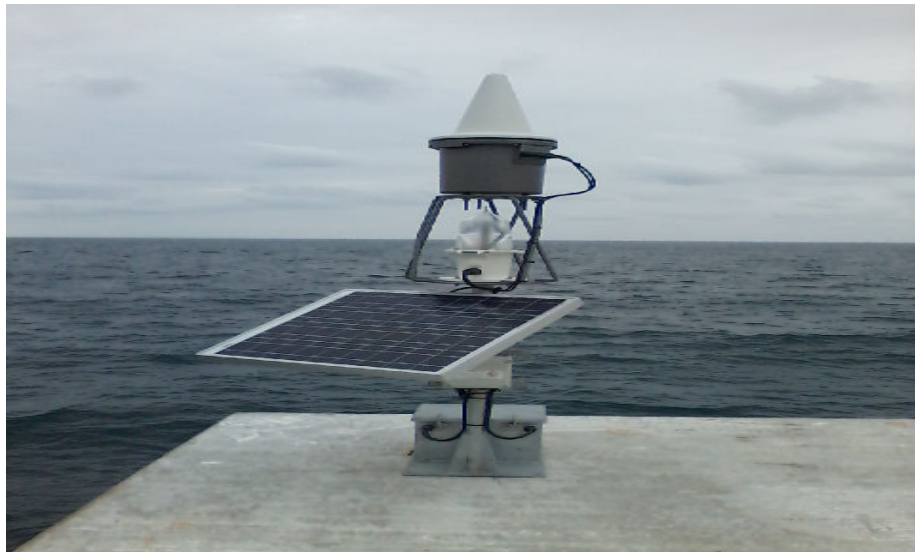
Ilustración 139.- instalación de ayudas a la navegación en dolfins de atraque
