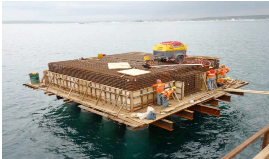
Ilustración 123.- armado con acero de refuerzo de losa y canaletas del puente de acceso
