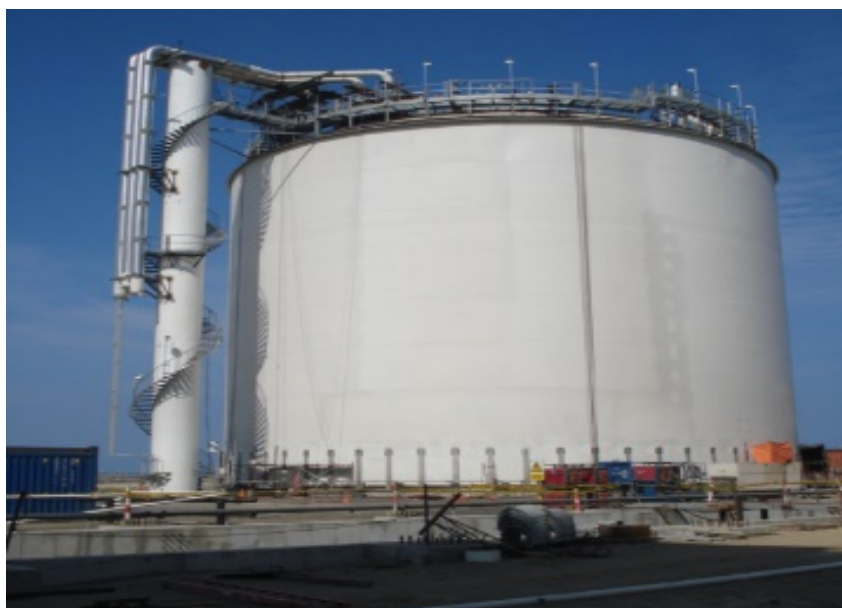
Ilustración 21.- tanques, esferas y salchichas armados
