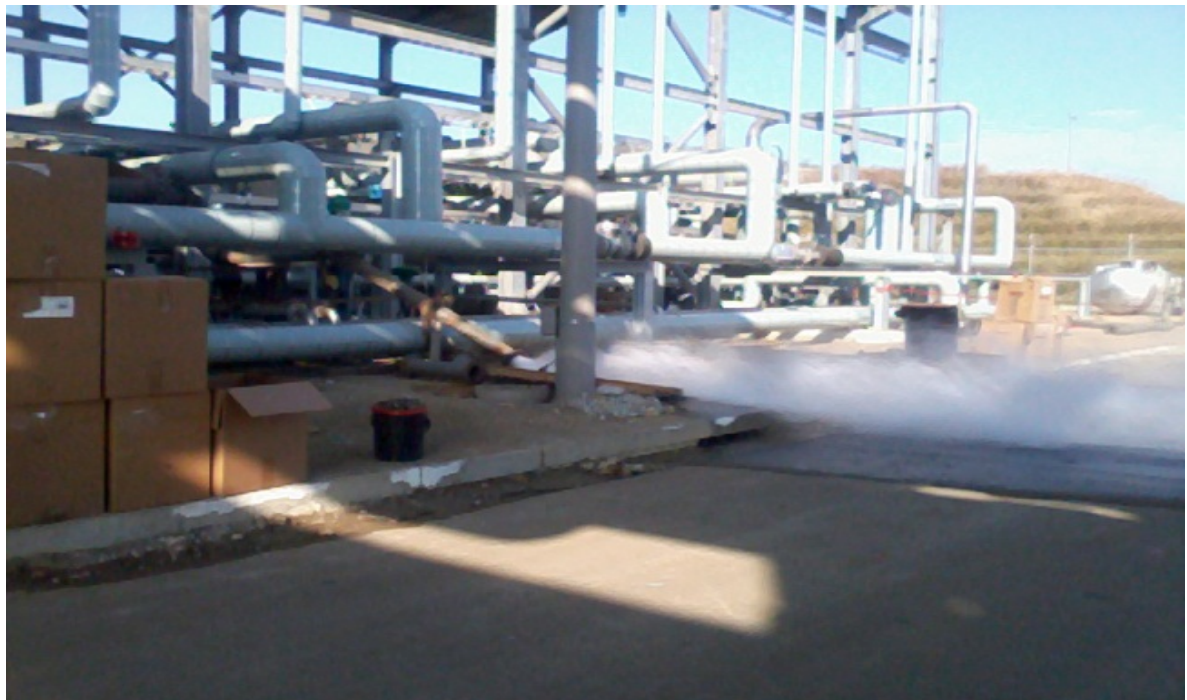
Ilustración 288.- flushing de líneas del paquete de frío
