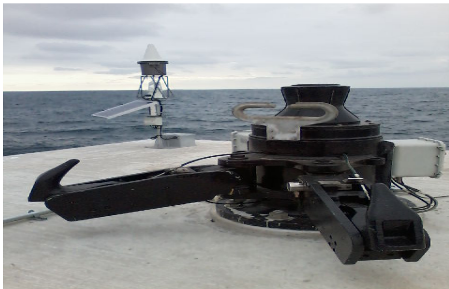
Ilustración 140.- ganchos de desenganche rápido y ayudas a la navegación en dolfins
