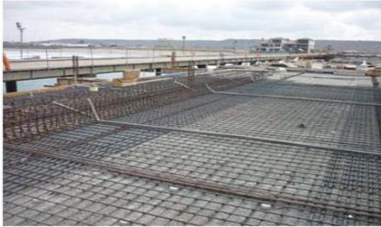
Ilustración 115.- encofrado y fundición de canaletas puente de acceso
