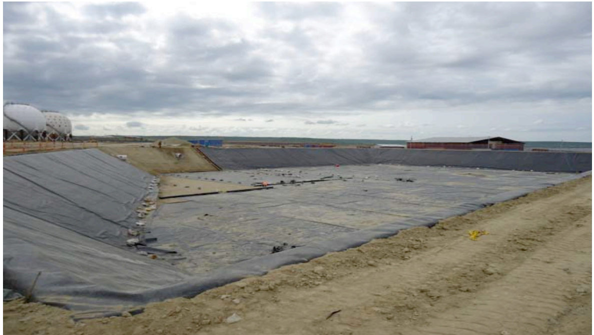
Ilustración 252.- colocación de linner en dique de contención de los tanques
