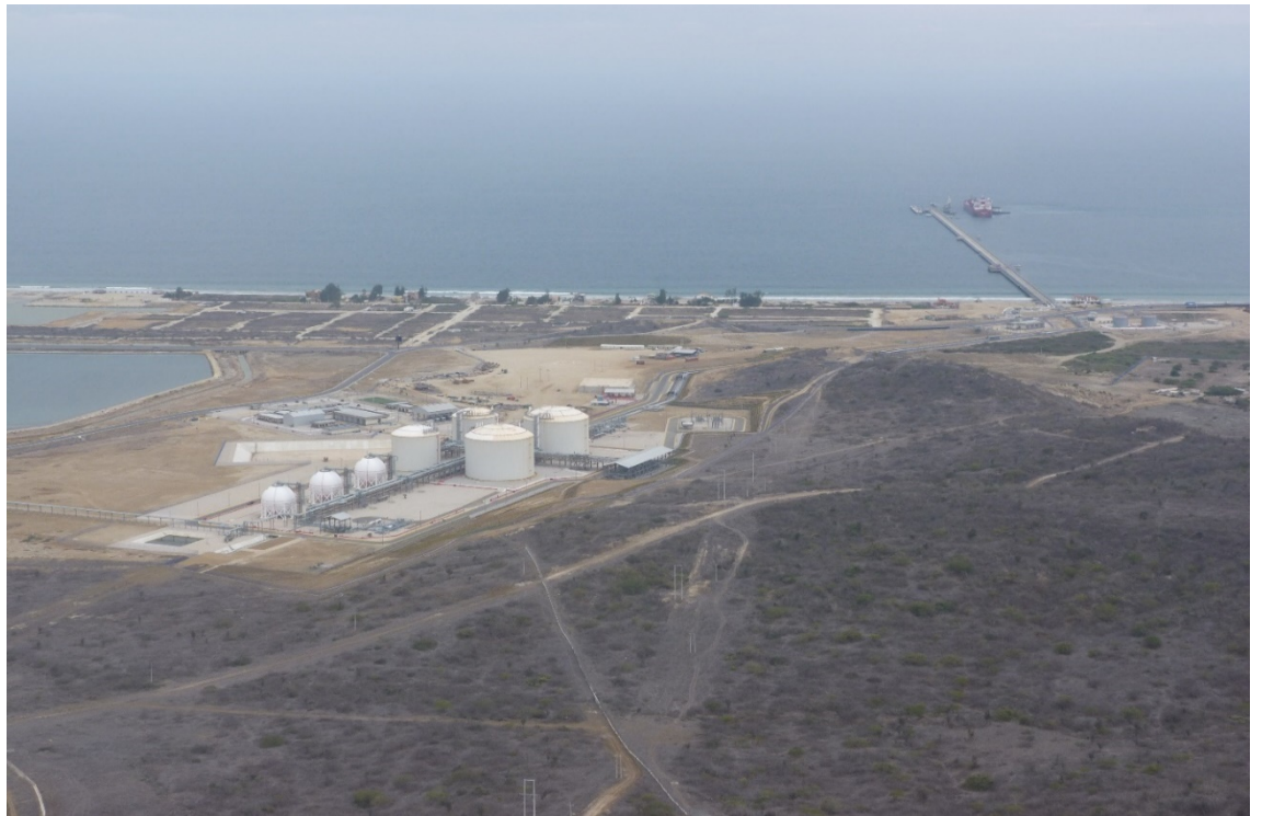
Ilustración 327.- avance de construcción del proyecto (año 2014)
