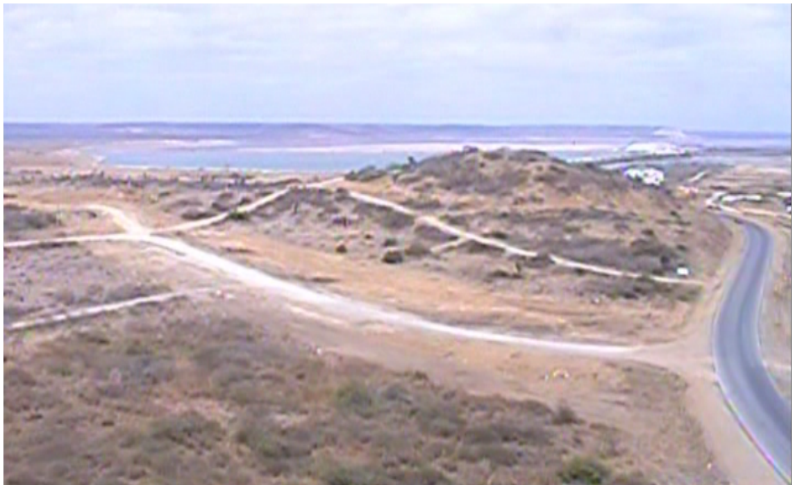
Ilustración 318.- área de construcción de la planta de almacenamiento en monterverde (año 2008)
