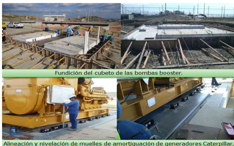
Ilustración 47.- avance de obras a junio 2012
