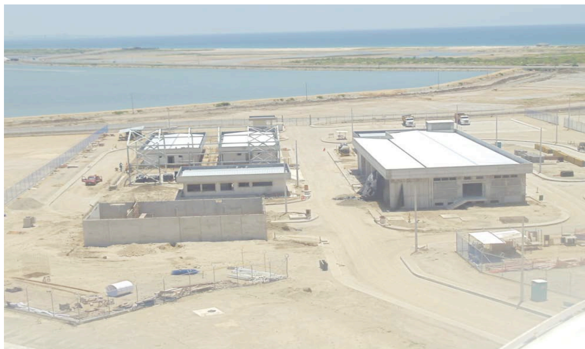
Ilustración 268.- enlucido de área administrativa
