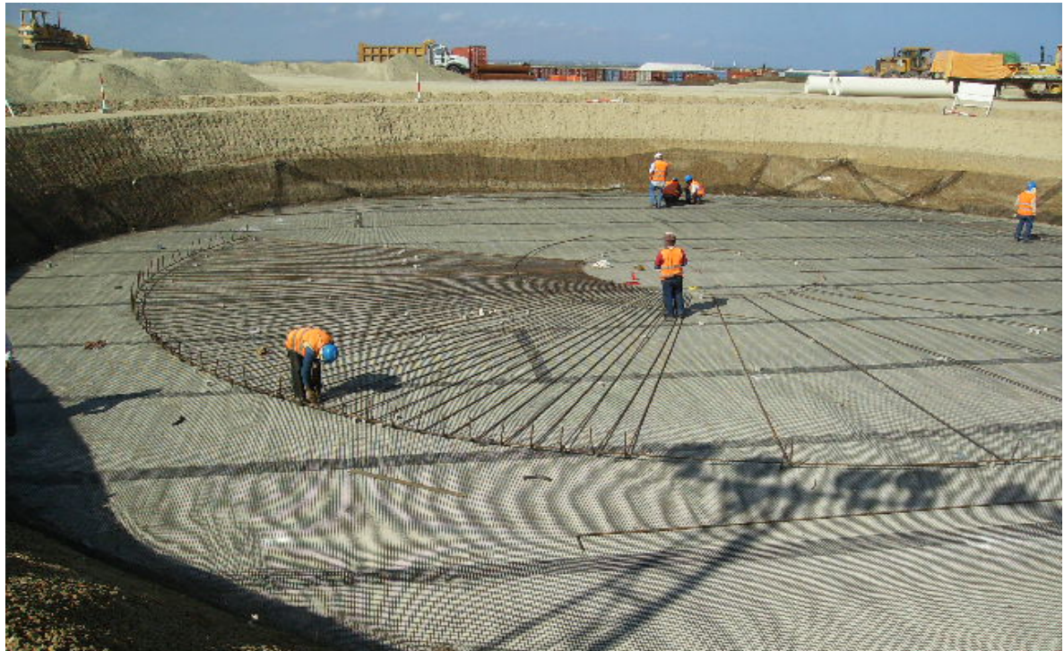
Ilustración 224.- conformado de suelo cemento tanque tq-0702 b
