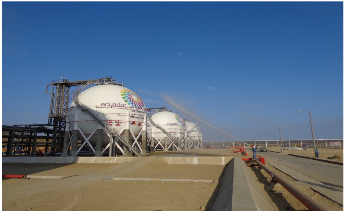
Ilustración 300.- comisionado del sistema contra incendio de las esferas
