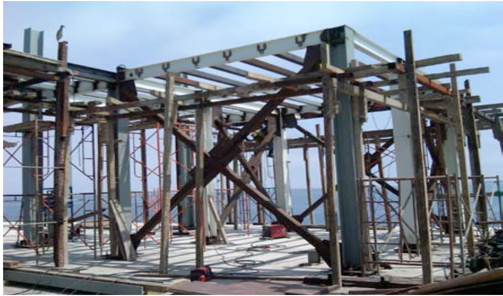
Ilustración 143.- montaje de la estructura metálica y planchas de estilpanel para losa del cuarto de control del muelle
