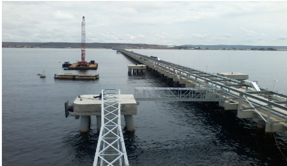
Ilustración 136.- colocación de las rejillas en el piso de las pasarelas
