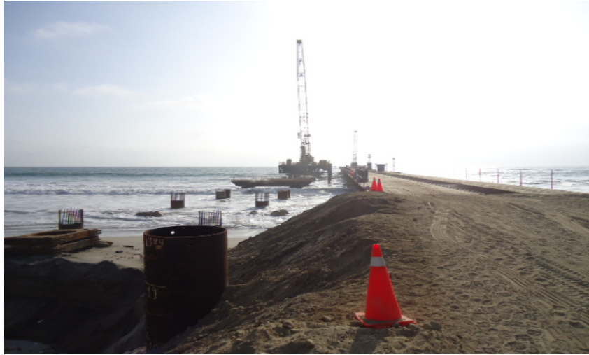
Ilustración 107.- pilotes hincados para armaduras y encofrados
