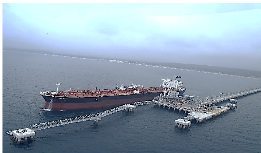
Ilustración 64.- conexión de escalera hidráulica del TMM AL B/T CHIMBORAZO
