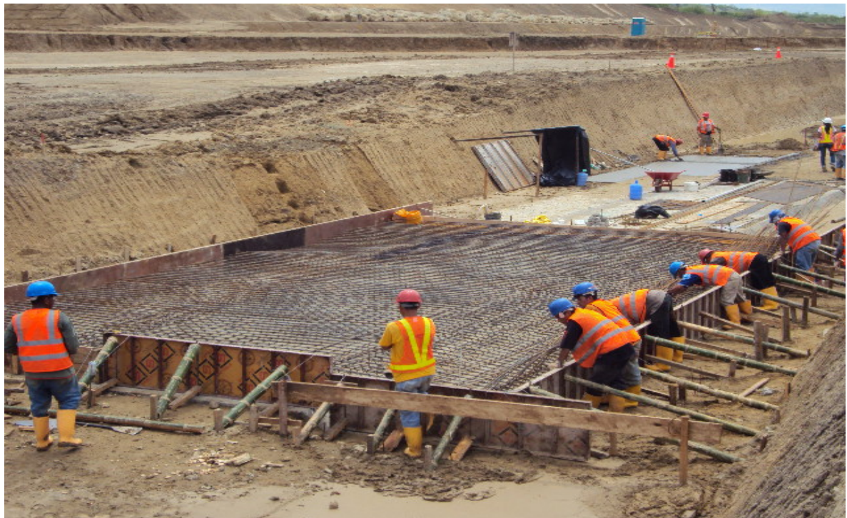
Ilustración 214.- armado de acero de refuerzo y encofrado en losa de piso de pipe-way
