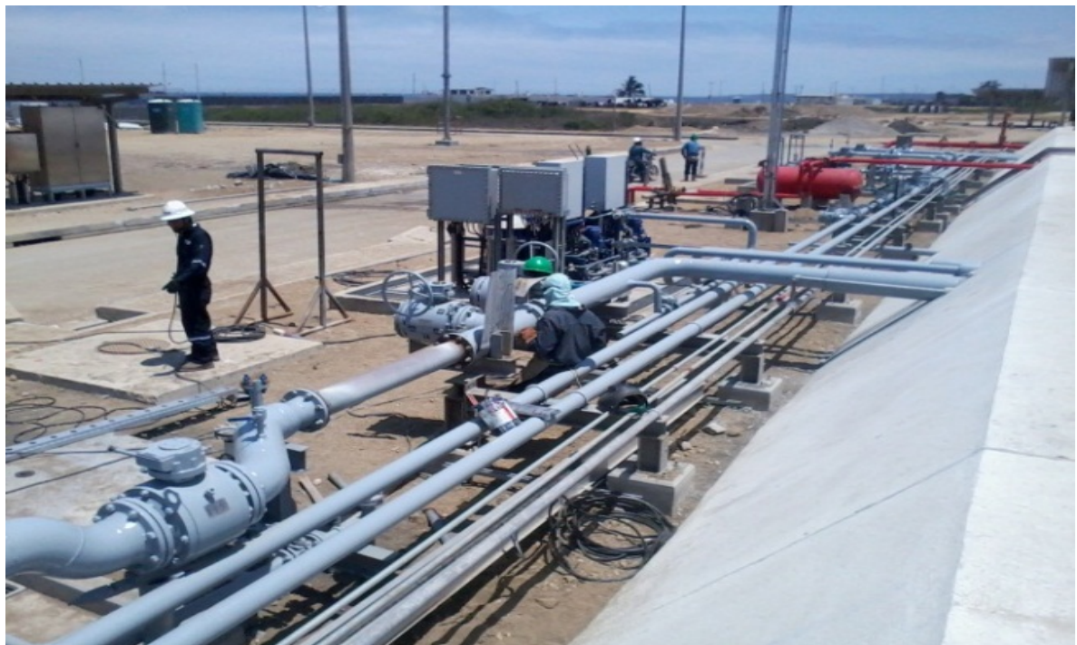
Ilustración 280.- montaje de filtros de diesel
