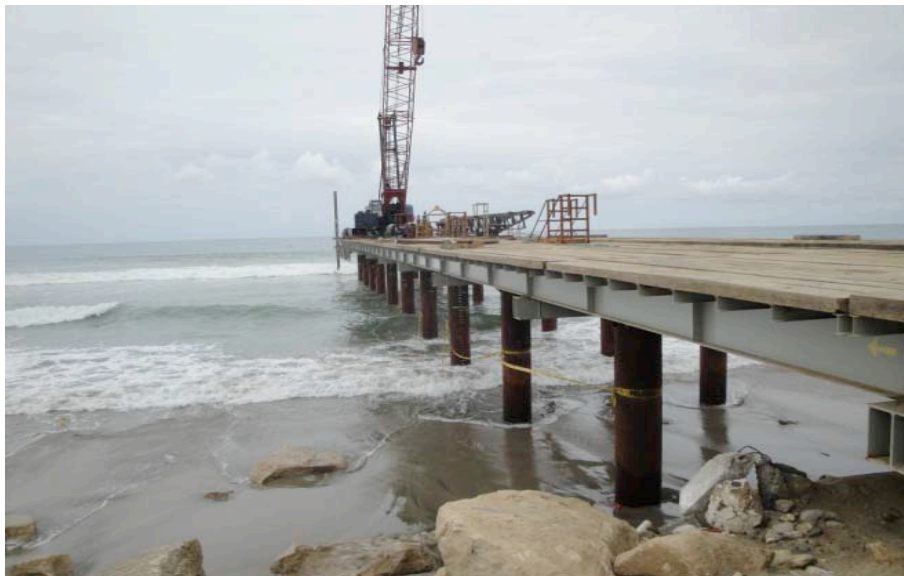
Ilustración 102.- muelle de servicio con los módulos de la superestructura colocados
