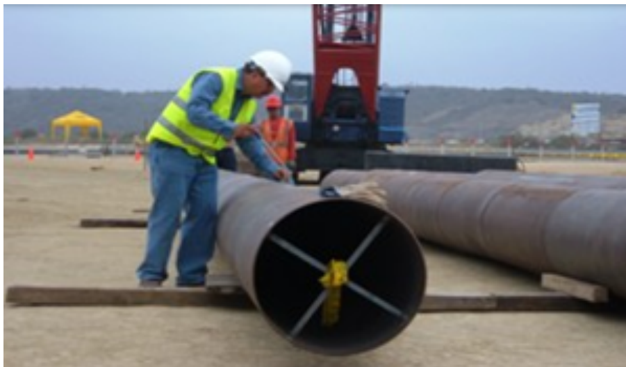
Ilustración 35.- inspección y análisis de pilotes
