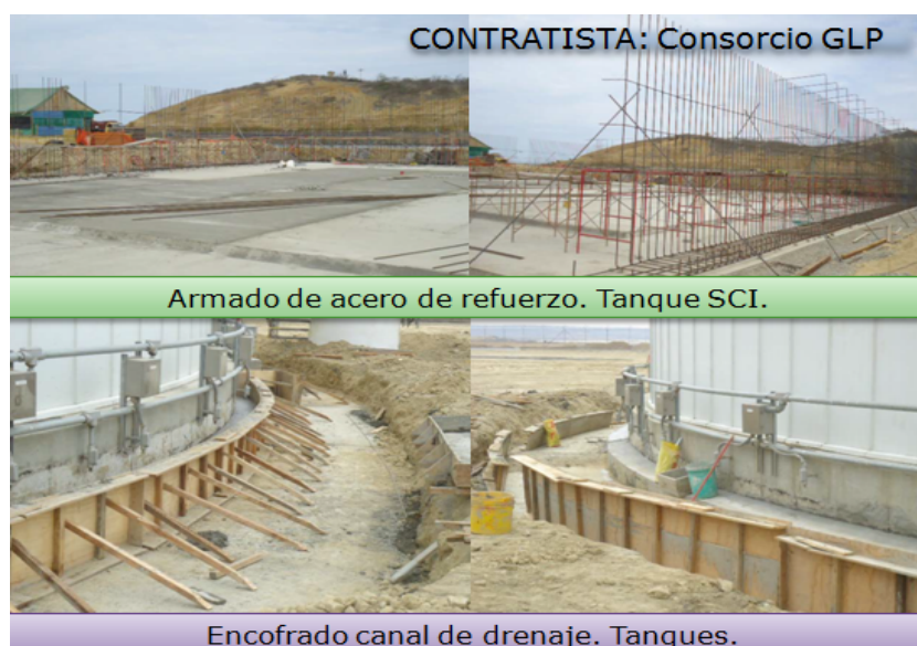
Ilustración 46.- ejecución de trabajos a enero 2012
