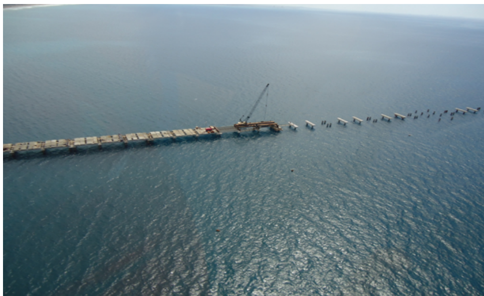
Ilustración 118.- vista aerea de avance de hinca de pilotes en muelle
