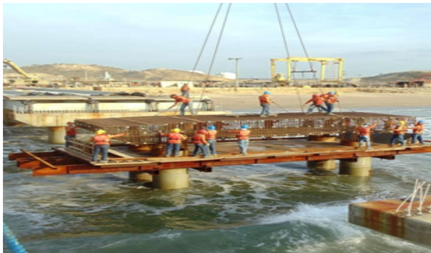
Ilustración 114.- armado del acero de refuerzo para losa (capa de compresión) y canaletas. Puente de acceso
