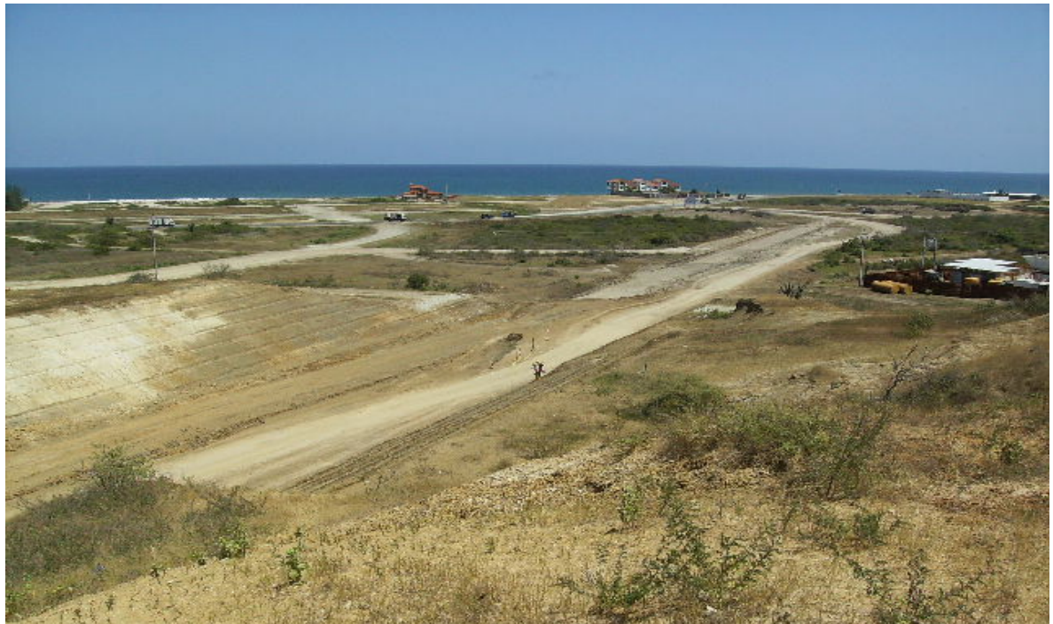
Ilustración 198.- movimiento de tierras en zona de tubovía
