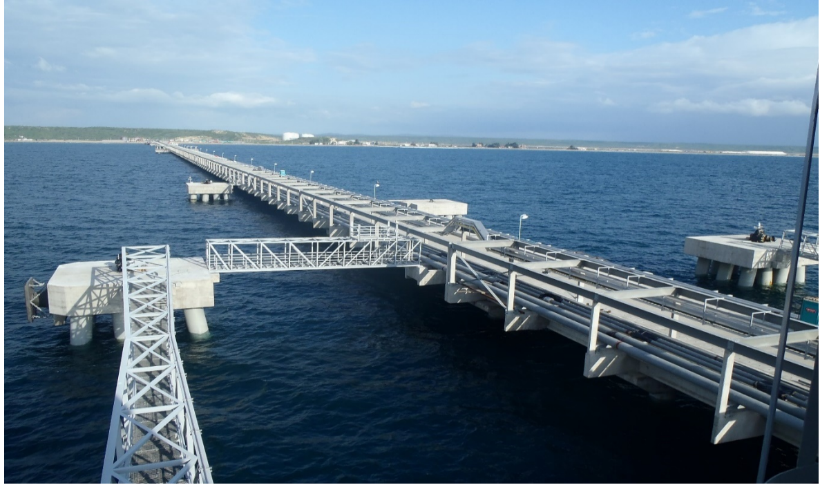
Ilustración 158.- vista lateral de tubovía en pantalán de acceso al muelle
