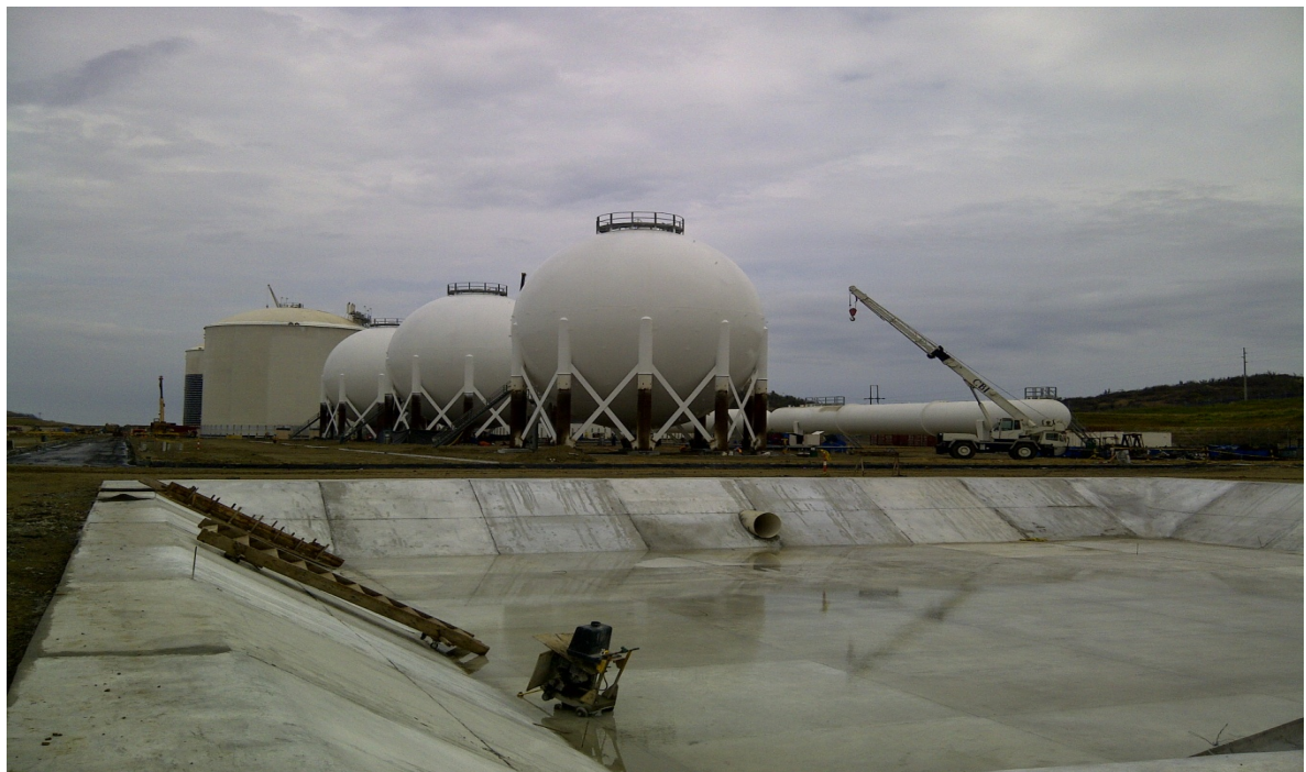
Ilustración 254.- dique de contención de esferas de glp
