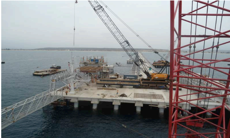
Ilustración 145.- vista panorámica de la plataforma de operación en construcción
