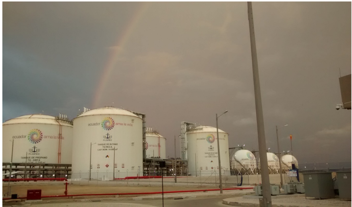
Ilustración 314.- vista panorámica de la planta de almacenamiento
