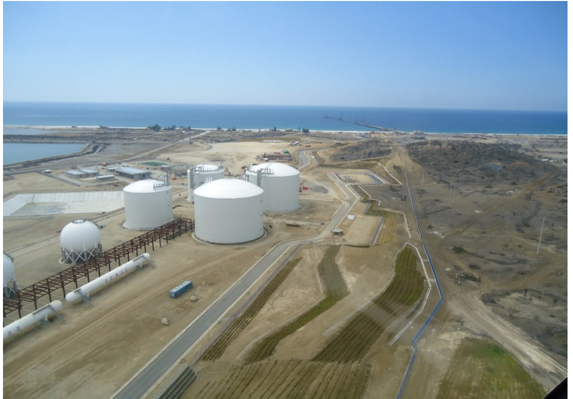
Ilustración 325.- avance de construcción del proyecto (año 2011)
