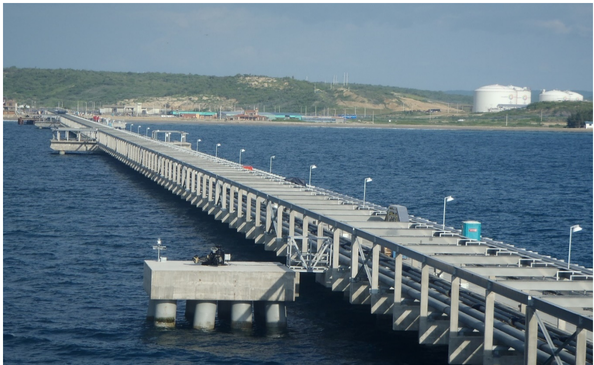
Ilustración 158.- vista lateral de tubovía en pantalán de acceso al muelle
