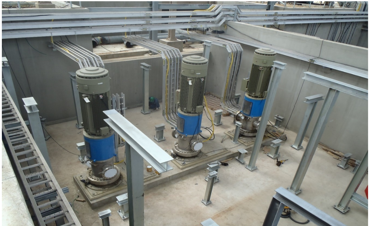
Ilustración 292.- instalación de bombas de procesos
