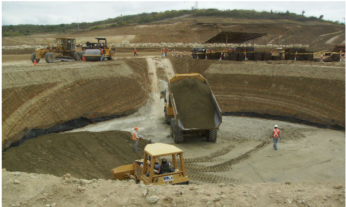
Ilustración 206.- trabajos de excavación y cimentación para esferas
