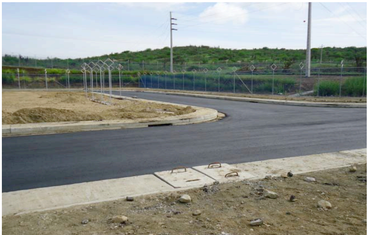
Ilustración 250.- pavimentación de la avenida 2
