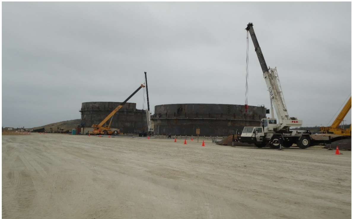
Ilustración 236.- avance de ensamblaje de tanques de propano y butano
