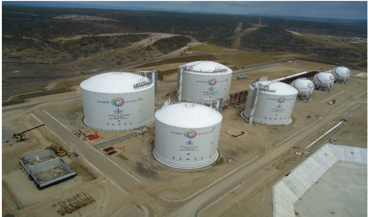
Ilustración 262.- vista panorámica de planta de almacenamiento
