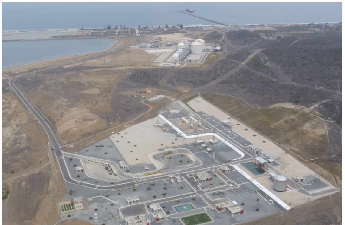
Ilustración 328.- avance de construcción del proyecto (año 2014)
