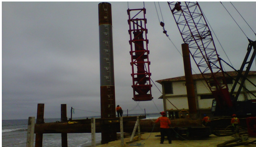
Ilustración 100.- hincado de pilotes de muelle de servicio
