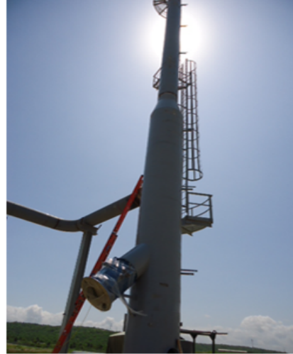
Montaje del Flare
