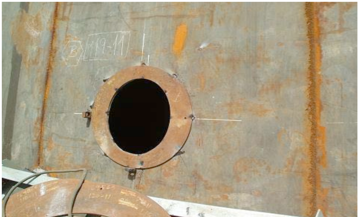
Ilustración 242.- instalación y soldadura de refuerzos en bocas del domo. Tanque tq-0501a
