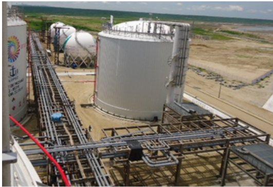
Montaje y soldadura de tuberías sobre la estructura del pipe rack
