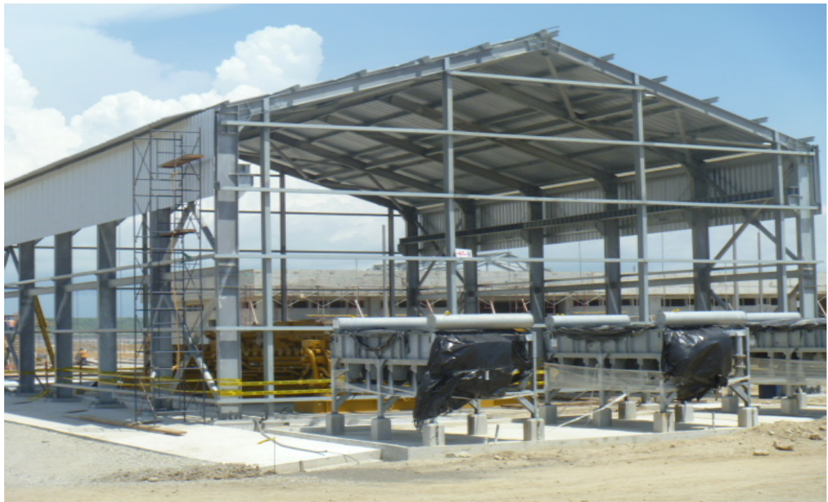
Ilustración 264.- montaje del cubierta en casa de. Generadores auxiliares.
