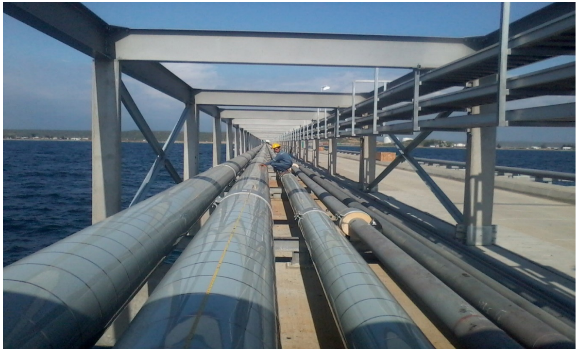
ILUSTRACIÓN 156.- INSTALACIÓN DE RECUBRIMIENTO TÉRMICO EN TUBERÍAS DE PROPANO Y BUTANO
