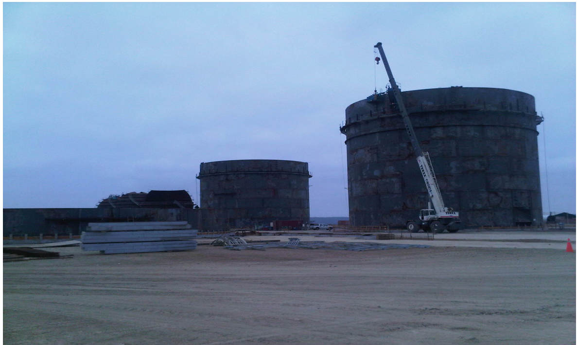
Ilustración 240.- avance de ensamblaje de tanques de propano y butano
