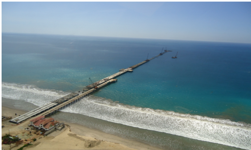
Ilustración 117.- vista panorámica de avance de construcción de muelle
