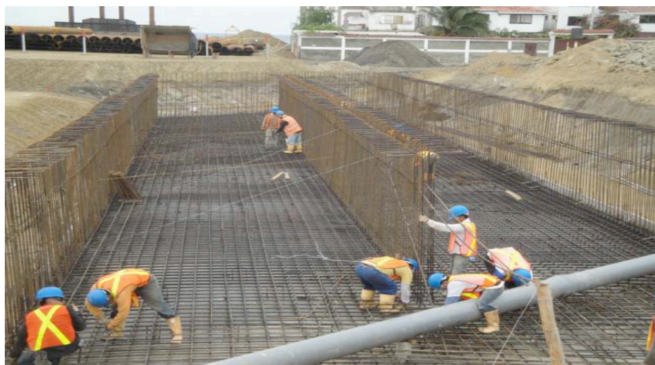
Ilustración 31.- refuerzo de losa y paredes de puente que cruza la vía “ruta del sol”
