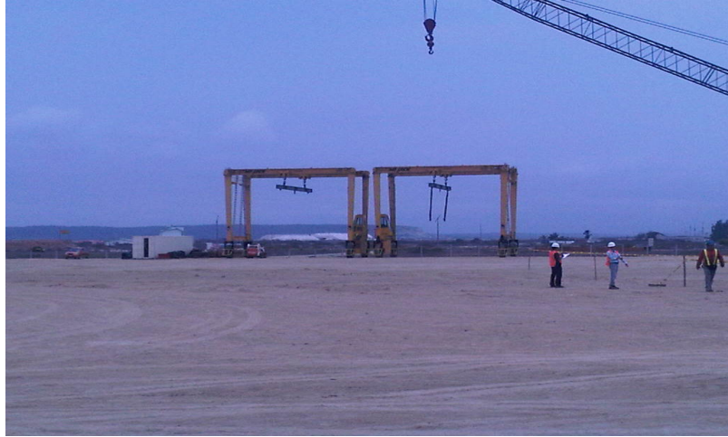
Ilustración 96.- recepción de planchas de acero
