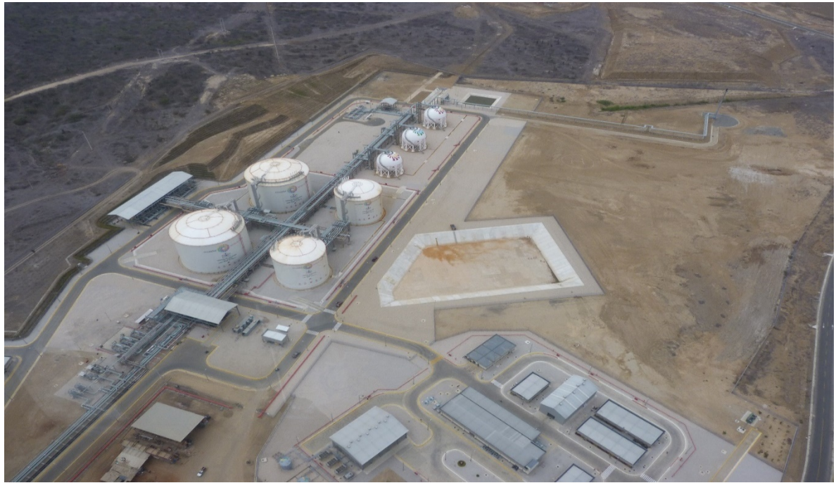
Ilustración 315.- vista aérea de la planta de almacenamiento
