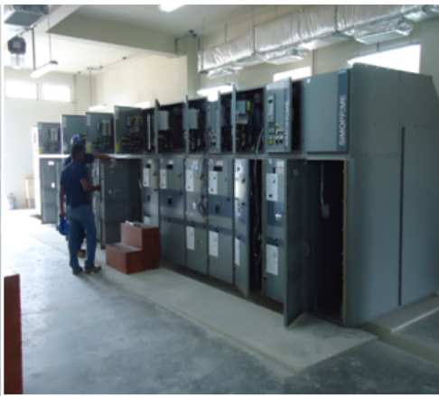
Montaje e instalación de los paneles eléctricos en la subestación SE-02
