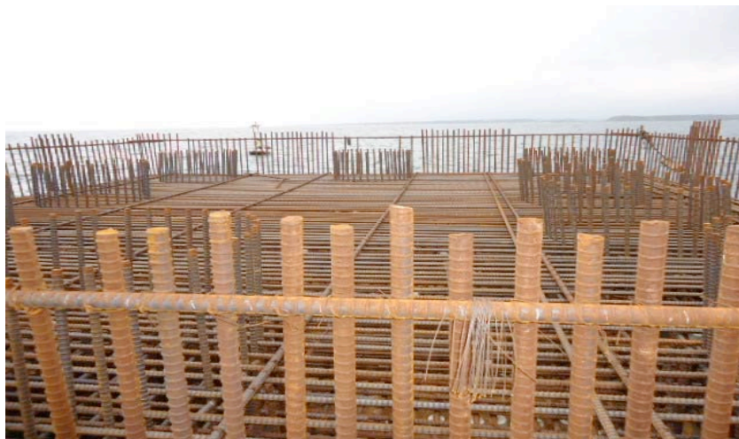
Ilustración 121.- armado con acero de refuerzo del cabezal del dolfin de amarre
