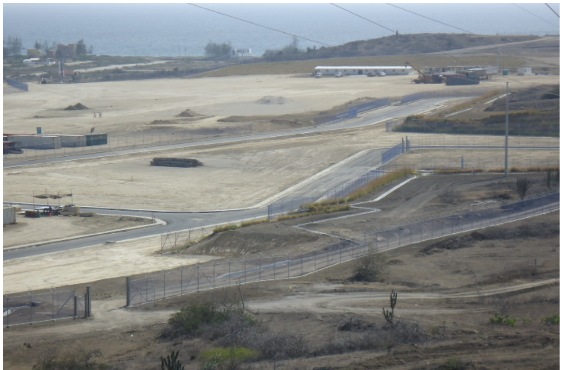
Ilustración 322.- avance de construcción del proyecto (año 2010)
