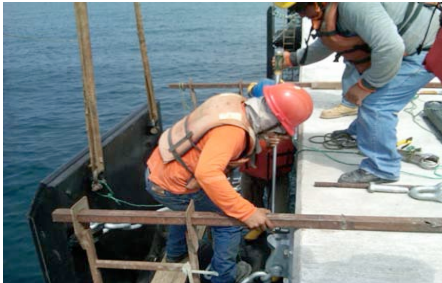
Ilustración 141.- instalación de defensas en muelle
