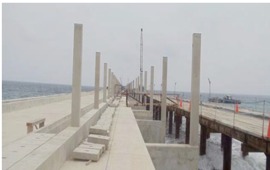
Ilustración 130.- construcción de columnas de hormigón sobre vigas transversales para pipe rack en puente de acceso
