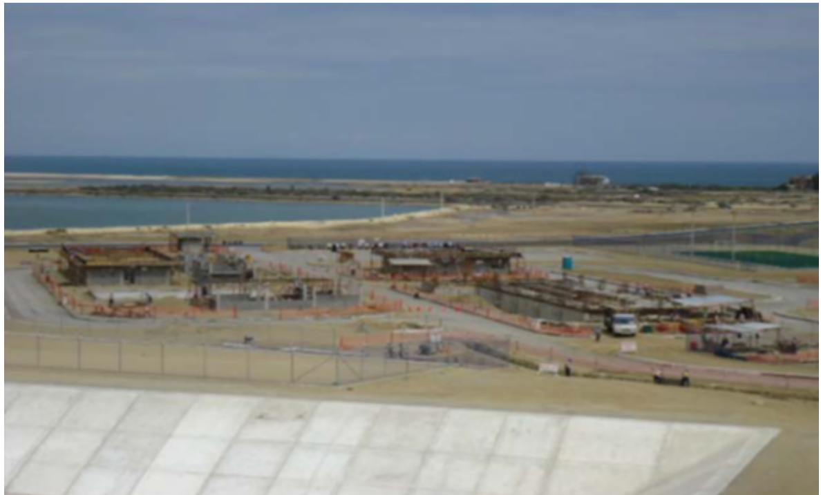
Ilustración 258.- vista panorámica de la construcción de facilidades
