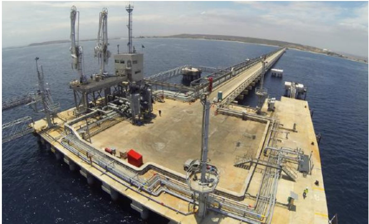
Ilustración 192.- vista frontal de tuberías de descarga de productos y facilidades portuarias durante descarga de glp
