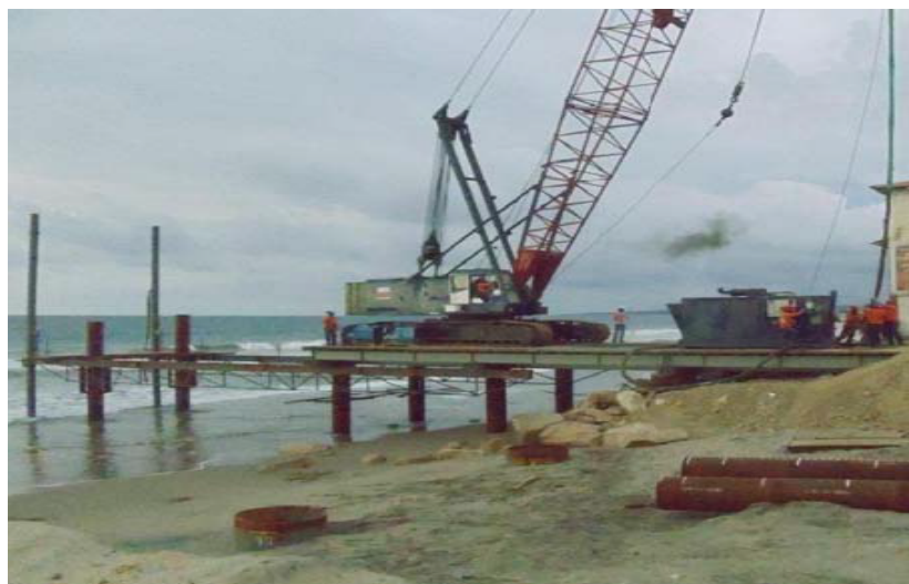
Ilustración 37.- hincado de pilotes de muelle auxiliar trabajo diurno y nocturno
