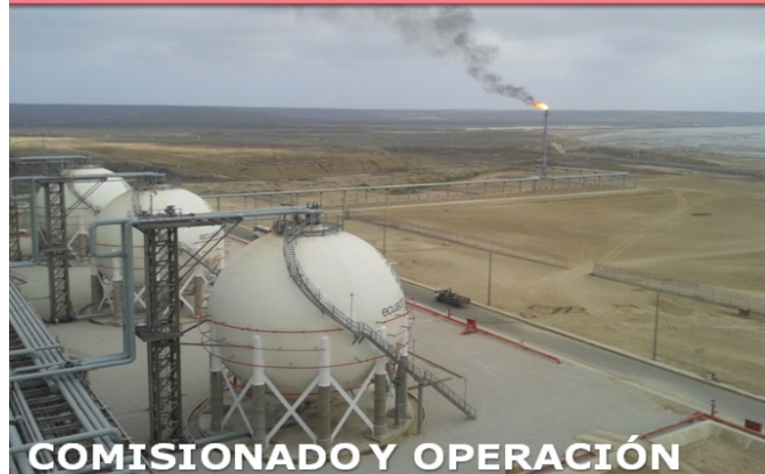
Llenado de Esferas con GLP, para posterior entrega a PEC.
