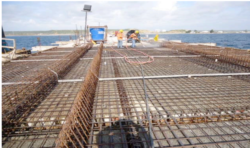
Ilustración 124.- fundición de losa del puente de acceso
