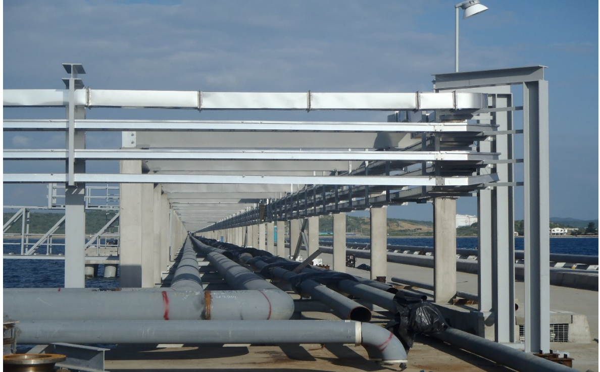
ILUSTRACIÓN 156.- INSTALACIÓN DE RECUBRIMIENTO TÉRMICO EN TUBERÍAS DE PROPANO Y BUTANO
