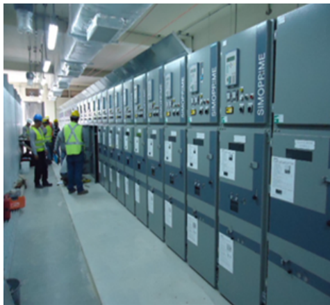
Montaje e instalación de los paneles eléctricos en la subestación SE-01.
