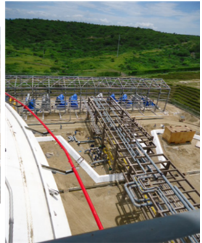
Montaje y soldadura de tuberías sobre la estructura del pipe rack
