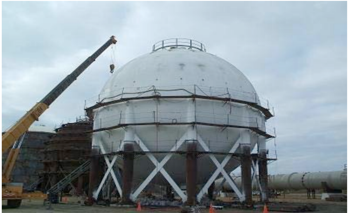
Ilustración 244.- segunda capa de pintura. Esfera ef-1301b
