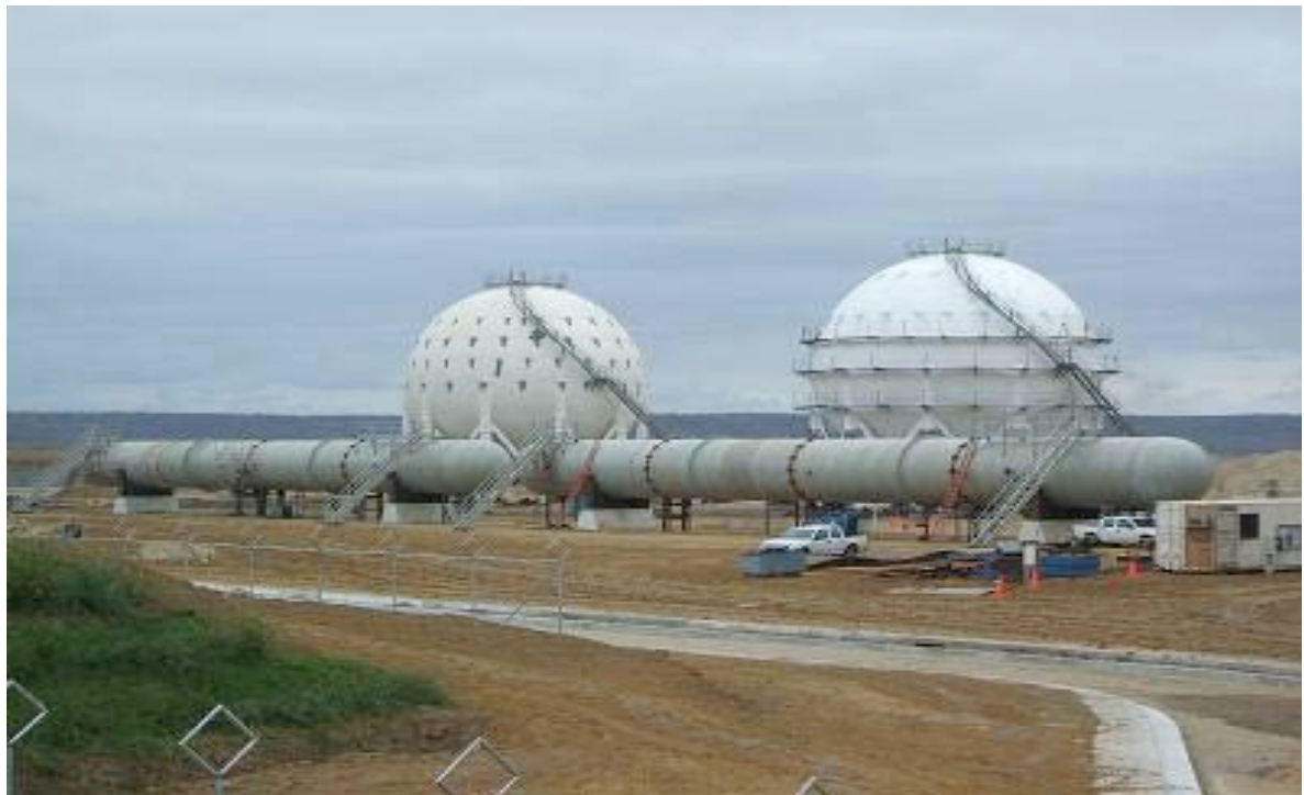
Ilustración 244.- segunda capa de pintura. Esfera ef-1301b
