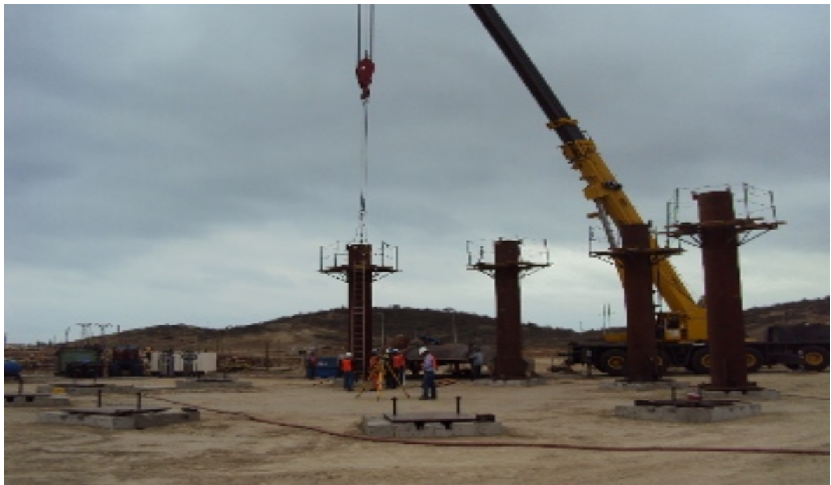
Ilustración 226.- izaje e instalación de bases de esferas para glp
