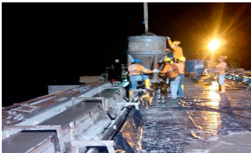
Ilustración 127.- fundición de canaletas en puente de acceso
