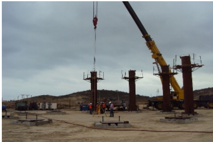
Ilustración 19.- construcción de esferas en obra
