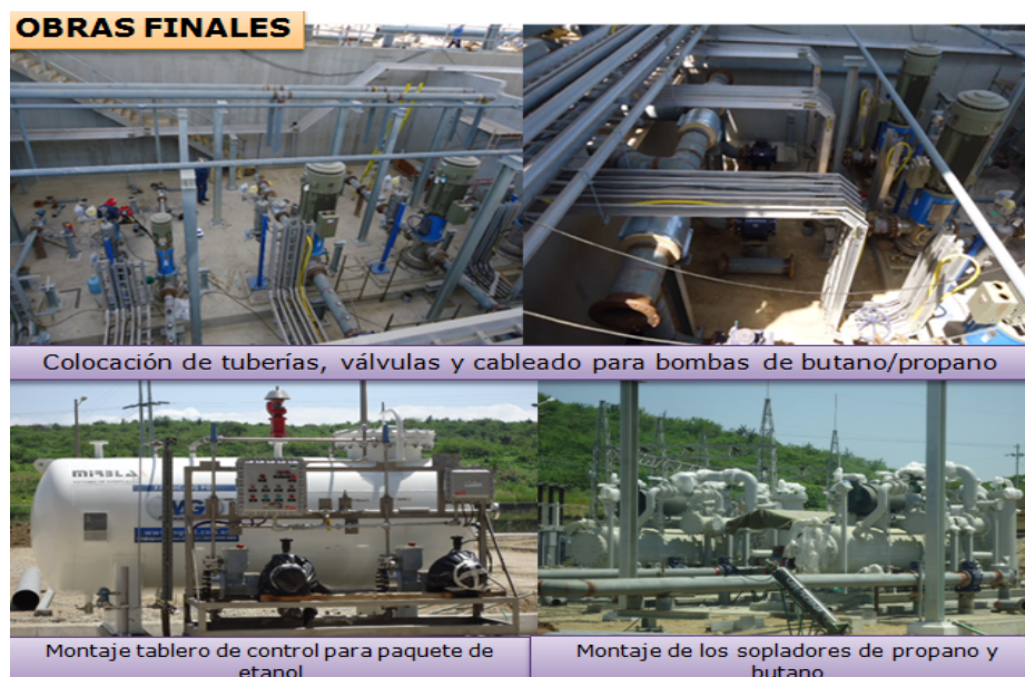
Ilustración 48.- avance de obra a marzo 2013
