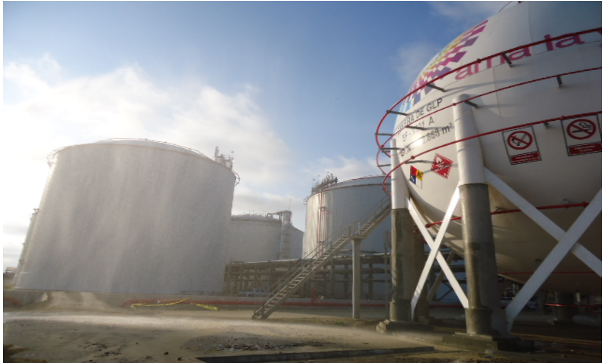
Ilustración 301.- comisionado del sistema contra incendio de los tanques
