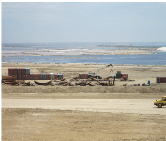
Ilustración 17.- planchas de acero para tanques en obra
