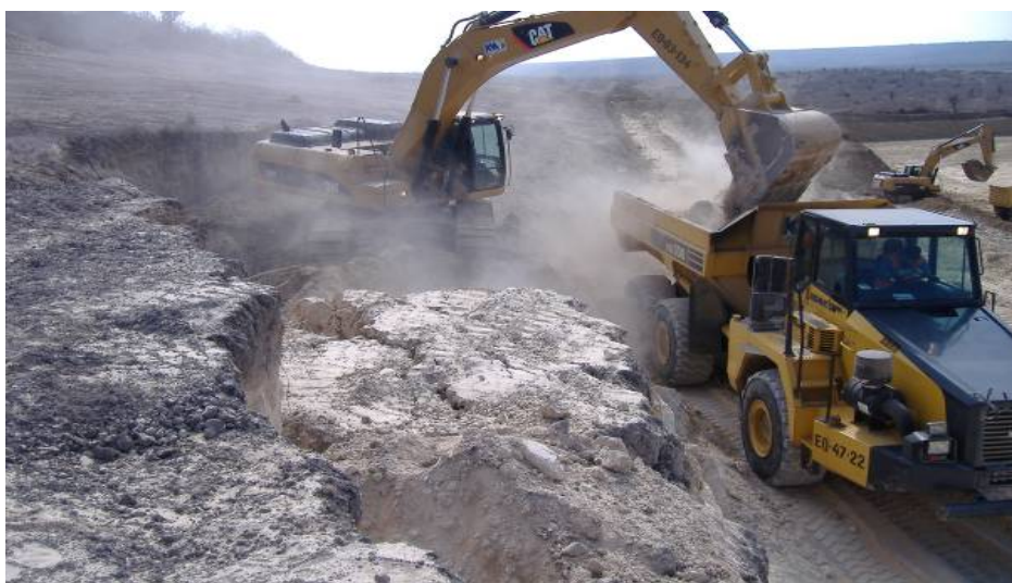
Ilustración 23.- excavación de taludes en area de tanques y esferas
