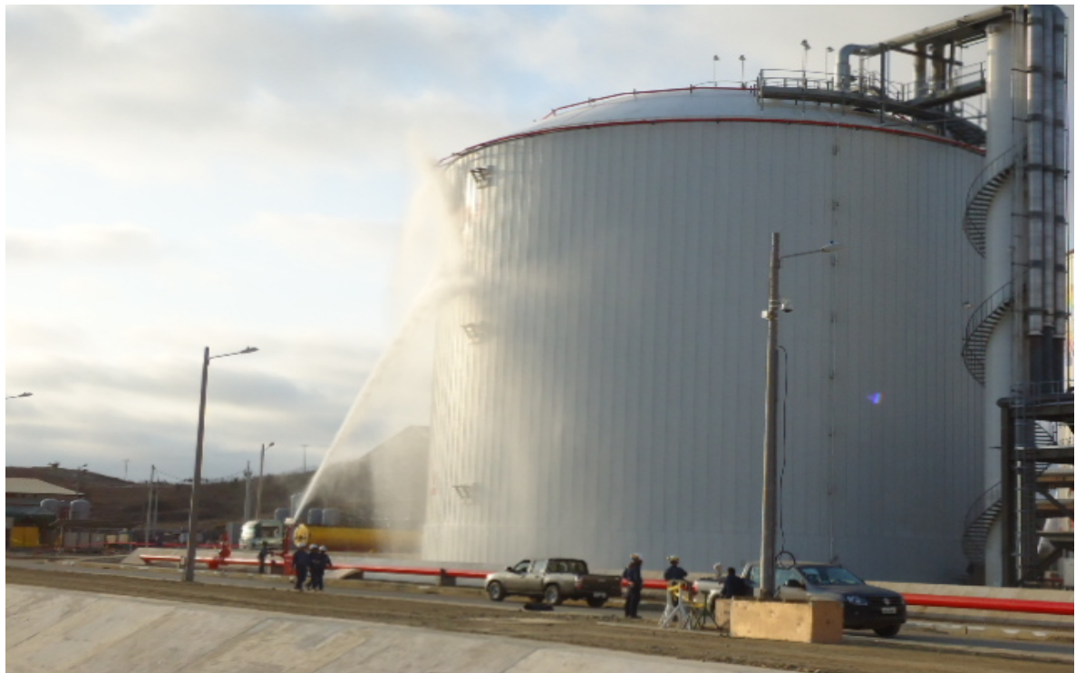
Ilustración 302.- comisionado del sistema contra incendio de los tanques
