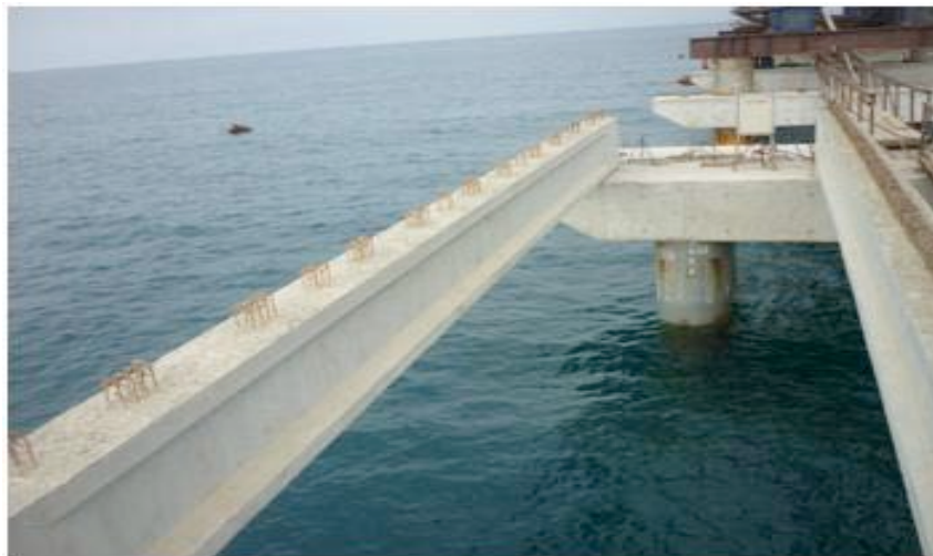
Ilustración 116.- montaje de vigas prefabricadas. Puente de acceso
