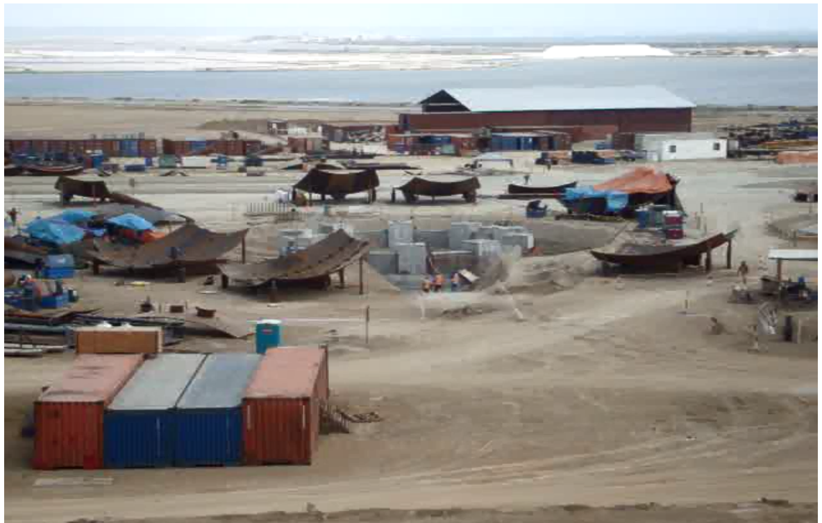
Ilustración 222.- trabajos de fundición de las bases de las esferas
