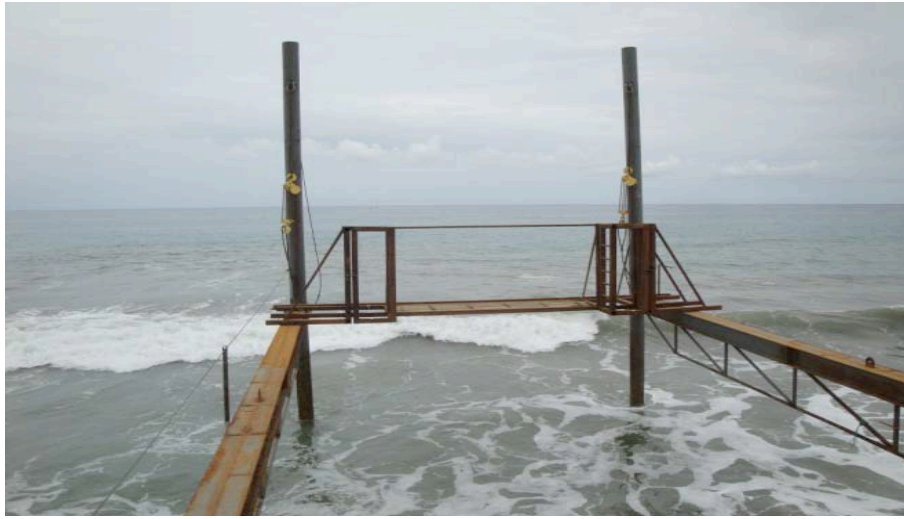
Ilustración 101.- guía para el posicionamiento de los pilotes previo al hincado (muelle de servicio).
