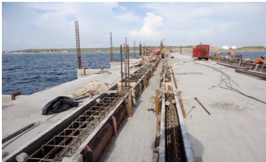
Ilustración 127.- fundición de canaletas en puente de acceso
