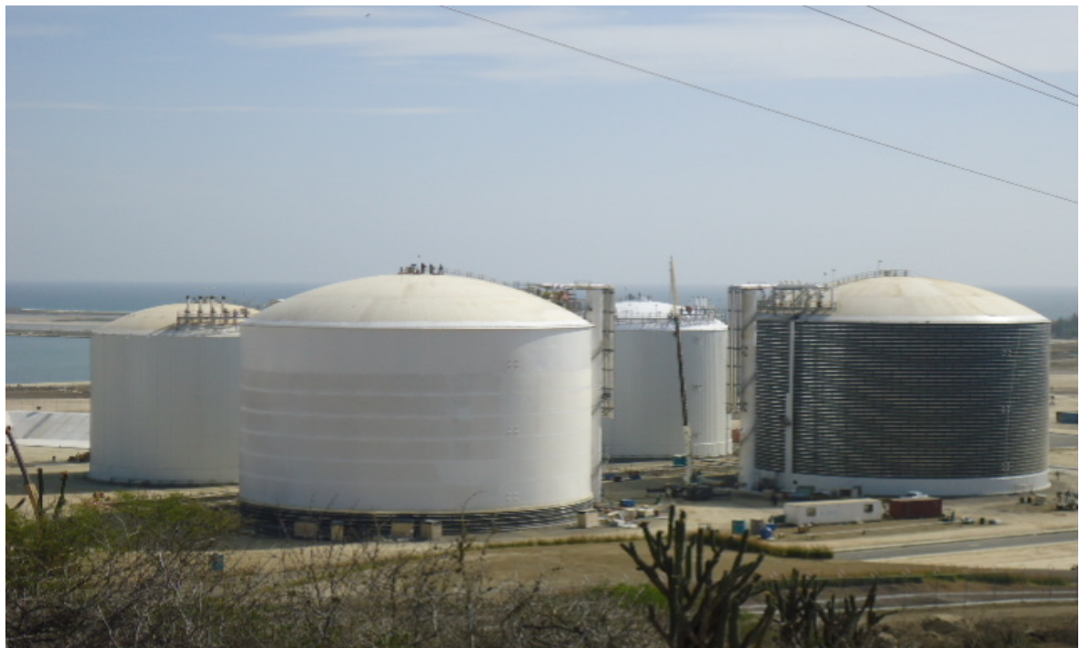
Ilustración 256.- instalación de recubrimiento térmico en tanques de propano y butano
