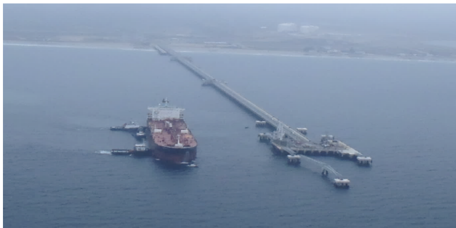
Ilustración 61.- vista de la maniobra de aproximación por la popa
