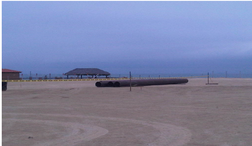
Ilustración 99.- inicio de hincado de pilotes de muelle de servicio
