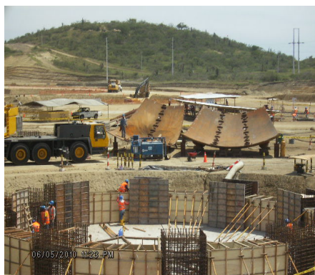
Ilustración 18.- planchas de acero para esferas en obra
