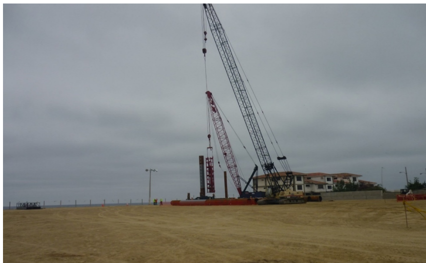
Ilustración 100.- hincado de pilotes de muelle de servicio
