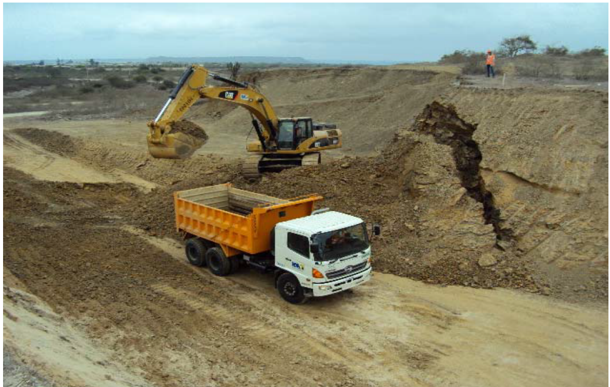
Ilustración 200.- excavación y perdilado de taludes
