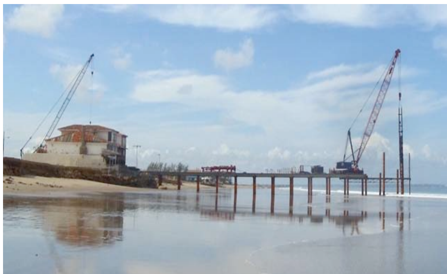
Ilustración 104.- avance de hinca de pilotes en el muelle de servicio
