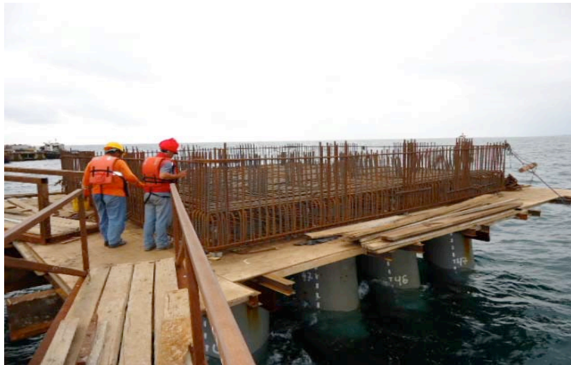
Ilustración 121.- armado con acero de refuerzo del cabezal del dolfin de amarre
