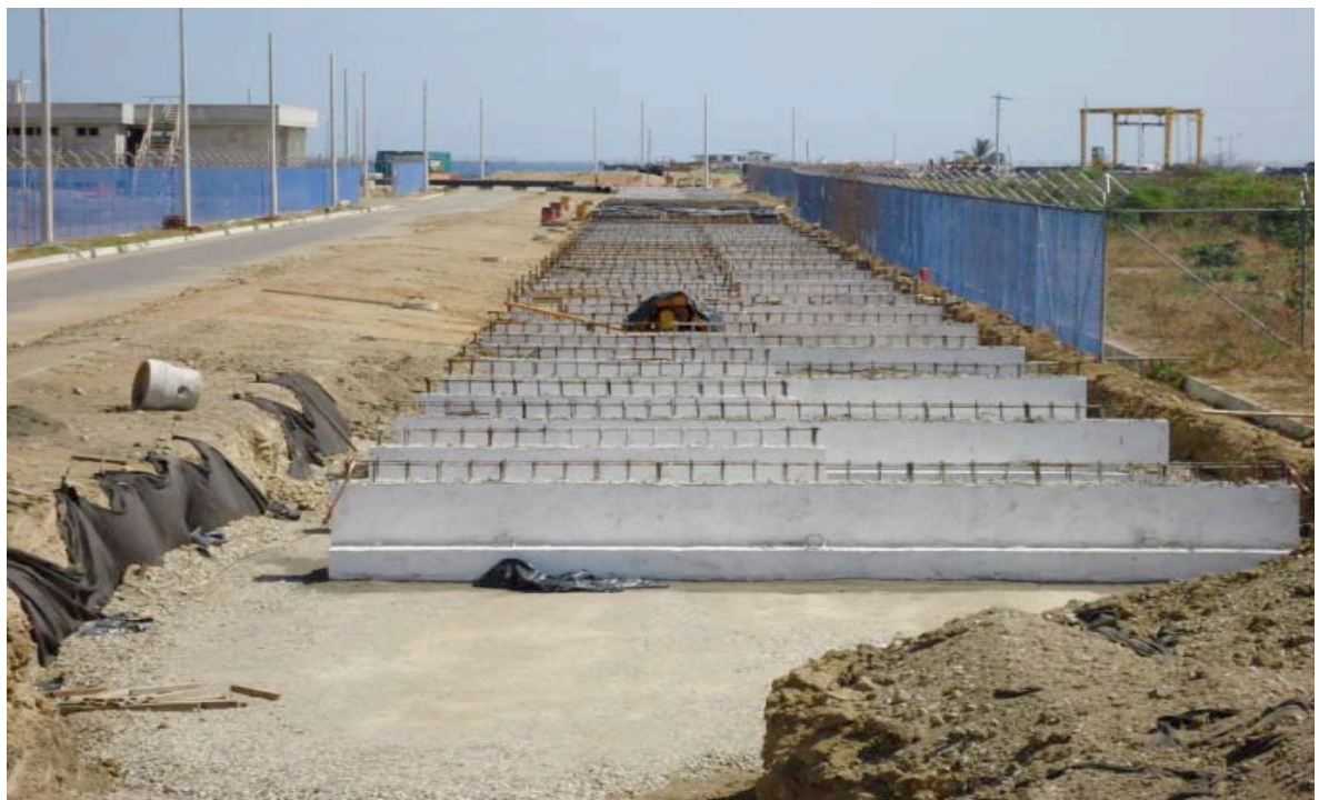
Ilustración 272.- relleno compactado con material de mejoramiento previo la colocación de los durmientes prefabricados
