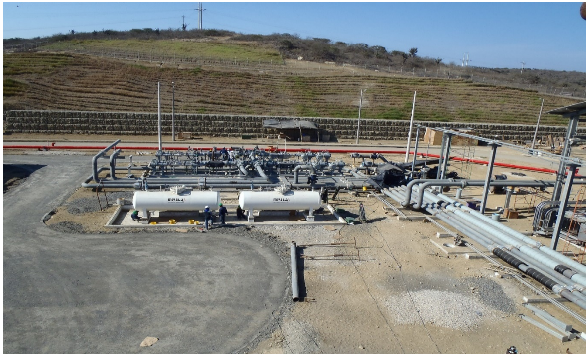
Ilustración 282.- sistema de odorización.
