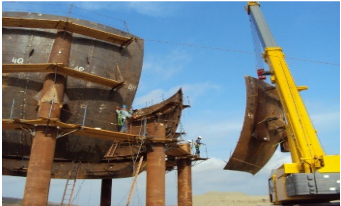
Ilustración 228.- avance de ensamblaje de esferas para glp
