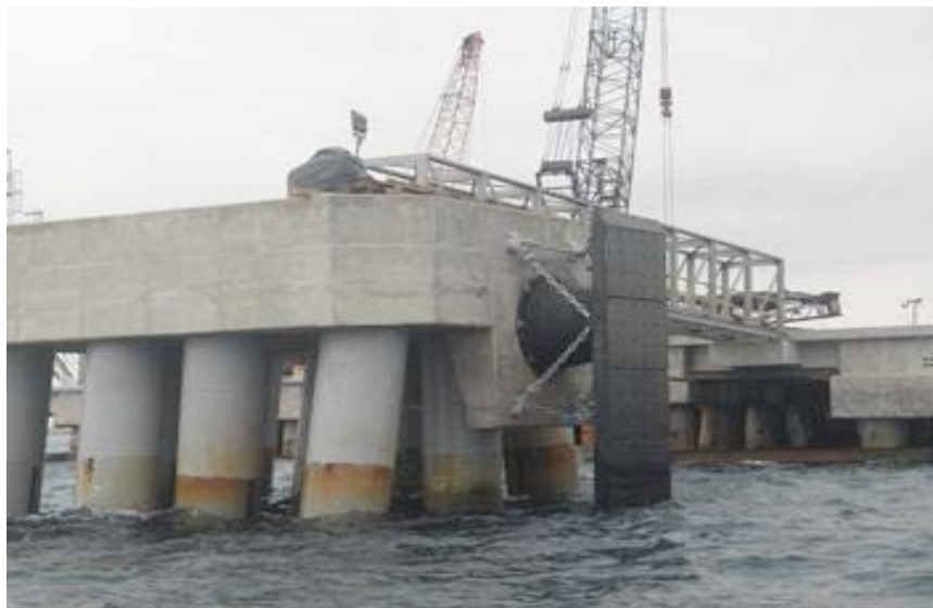
Ilustración 142.- instalación de defensas en dolfins
