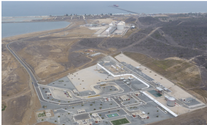
Ilustración 74.- vista del terminal marítimo, planta de almacenamiento de GLP construido por flopec y estación de bombeo construida por Petroecuador
