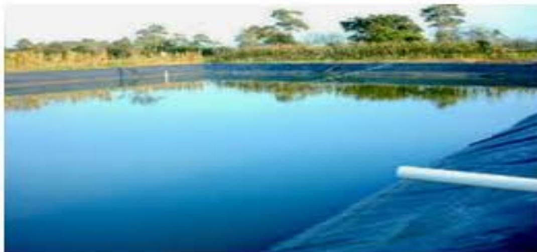
Figura 2.22. Reservorio de agua para riego basado en ABM. Geosintéticos y Sistemas Riego (2010)
