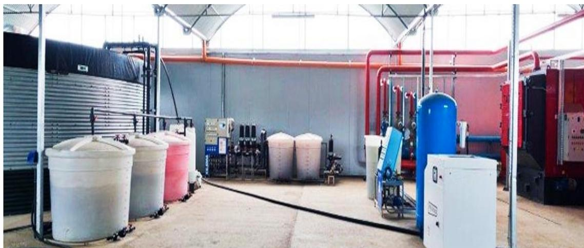
Figura 2.28. Tanques para fertilización<sup>22</sup>
