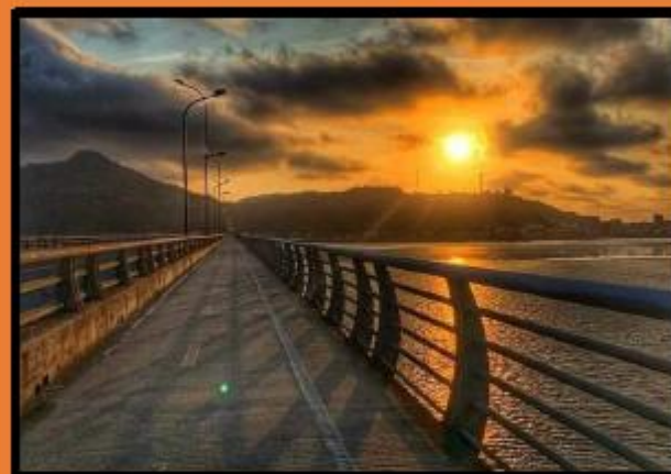
Puente Los Caras, conexión vial entre los cantones Sucre y San Vicente
