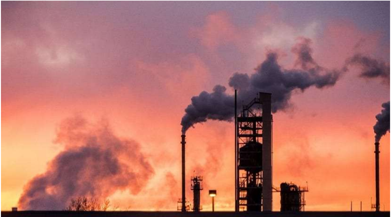
Ilustración 10. Central eléctrica no renovable.
