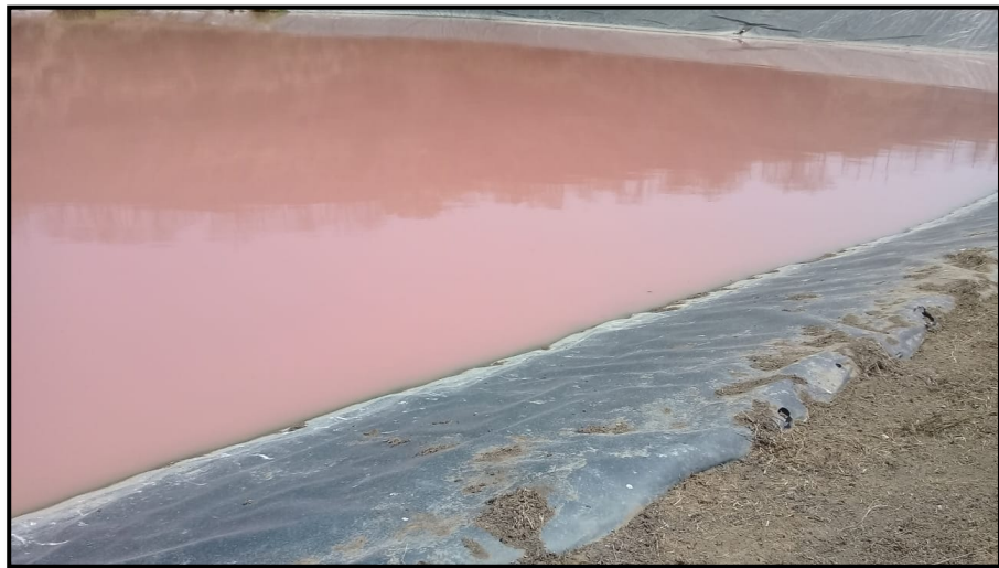
Ilustración 6: Laguna de maduración
