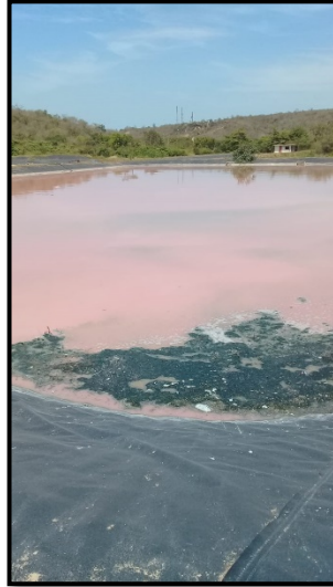
Ilustración 5: Laguna de maduración
