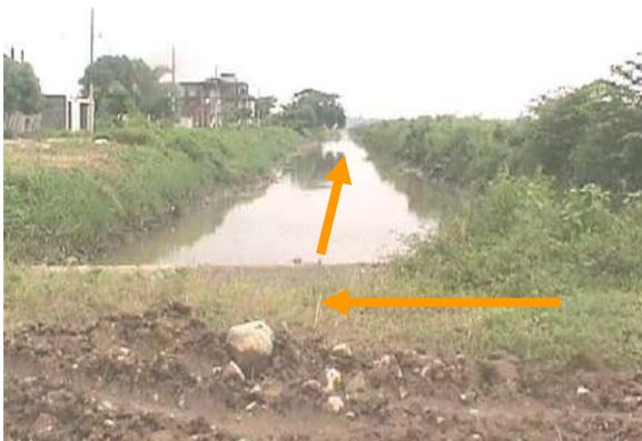
Figura 20.- Empate de drenajes con ángulos de 90°
