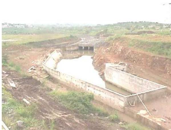
Figura 23.- Ducto Cajón en Av. Orellana y Vía Perimetral. Canal taponado durante obras
