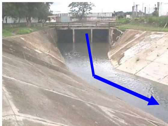
Figura 108.- Canal Trapezoidal, flecha indica pendiente de canal
