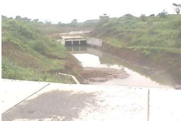
Figura 22.- Agua Estancada en Ducto Cajón en Av. Orellana y
