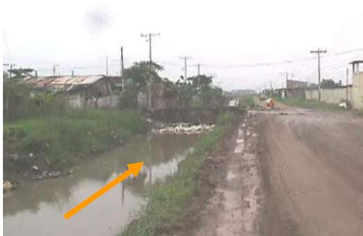
Figura 18.- Caudal Av. I. Ayora, obstruido por sedimento, basura y palizada
