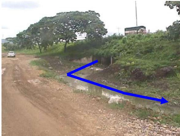
Figura 94.- Canal \_ducto cajón- proveniente de Flor de Bastión, que pasa por debajo de la. La flecha indica la dirección de la escorrentía
