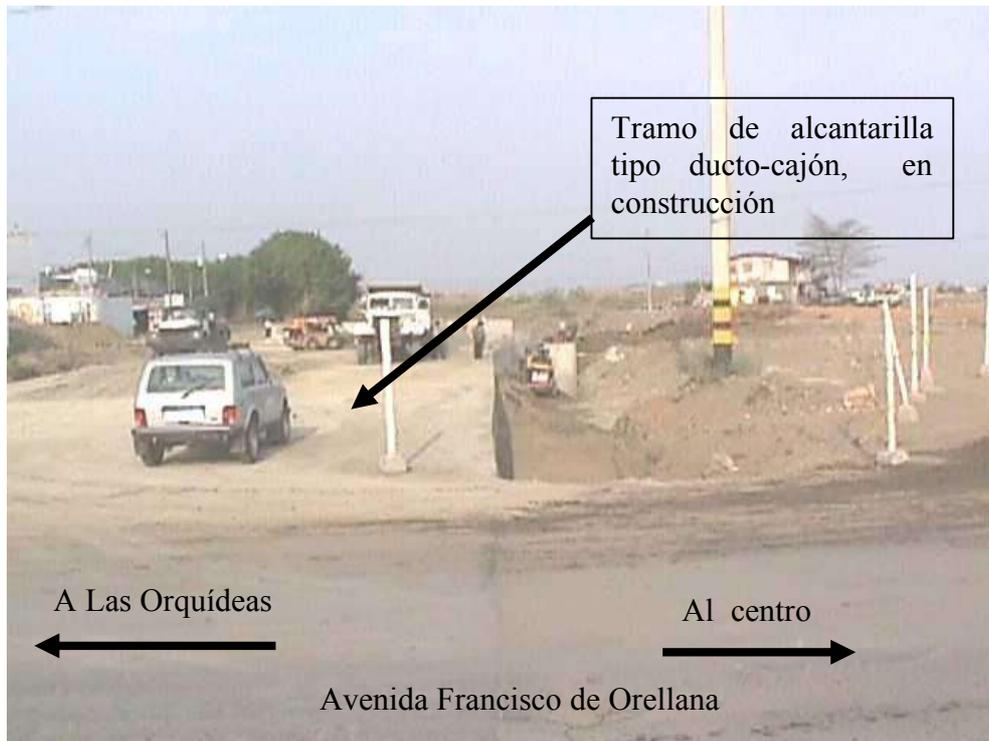
Figura 155.- Tramo de alcantarilla tipo Ducto-Cajón
