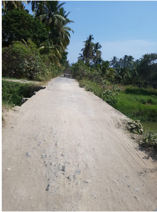
Ilustración 17.- Vía de acceso a Las Gilces
