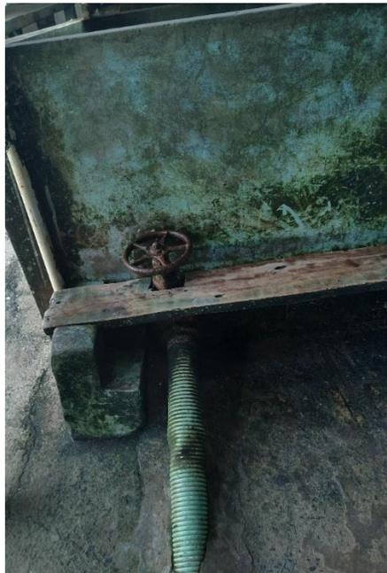
**Ilustración 3.** Sistema de drenaje del reservorio de agua, directo al mar
